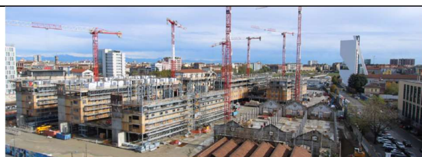
Figura 4.7 – Milano Olympic & Paralympic Village – cantiere costruzione a inizio novembre 2023
