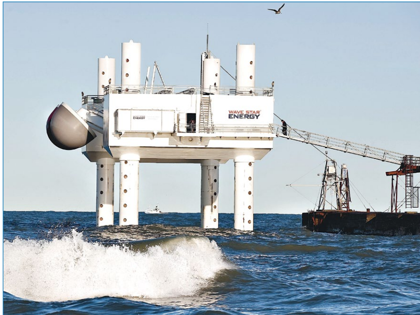
Wellenkraftversuchsanlage in der Nordsee vor der Küste Dänemarks in der Nähe von Hanstholm. Die Anlage steht mit vier Stützen fest auf dem Meeresboden. Überdimensionale Schwimmer werden von den Wellen auf und ab bewegt und produzieren so Strom.
