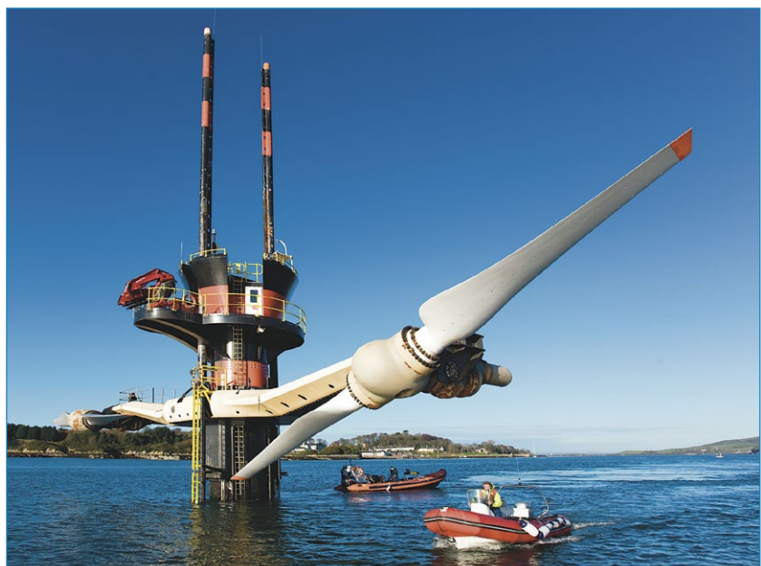
Strom aus Gezeitenströmungen: Die Anlage SeaGen in der irischen See liefert 1,2 MW Strom und kann etwa 1 500 Haushalte versorgen. Dabei treiben die Meeresströmungen, die durch Ebbe und Flut entstehen, zwei große Unterwasser-Rotoren an.
