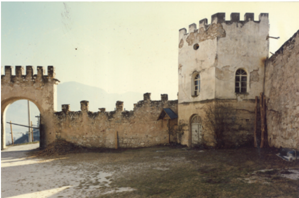
Der Innenhof vor der Restaurierung
