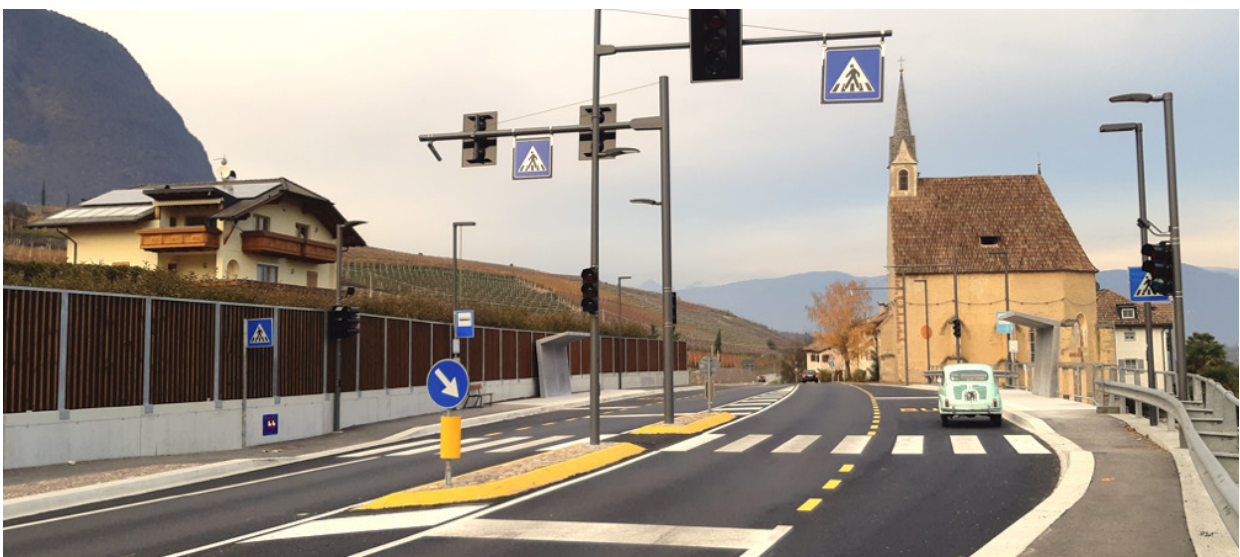
Bild A-5 Haltestelle außerhalb der Fahrbahn und Fußgängerübergang Fig. A-5 Fermata fuori carreggiata con attraversamento
