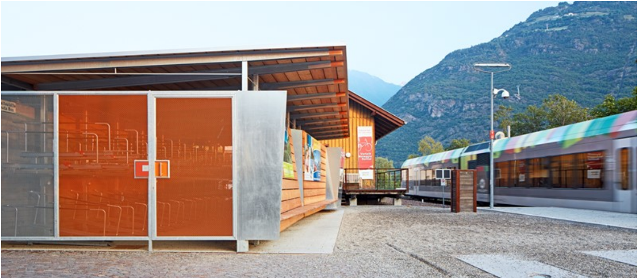
Abbildung 128 Beispiel einer Radstation für die sichere Unterbringung von Fahrrädern in Naturns [Quelle: STA/Riller]
