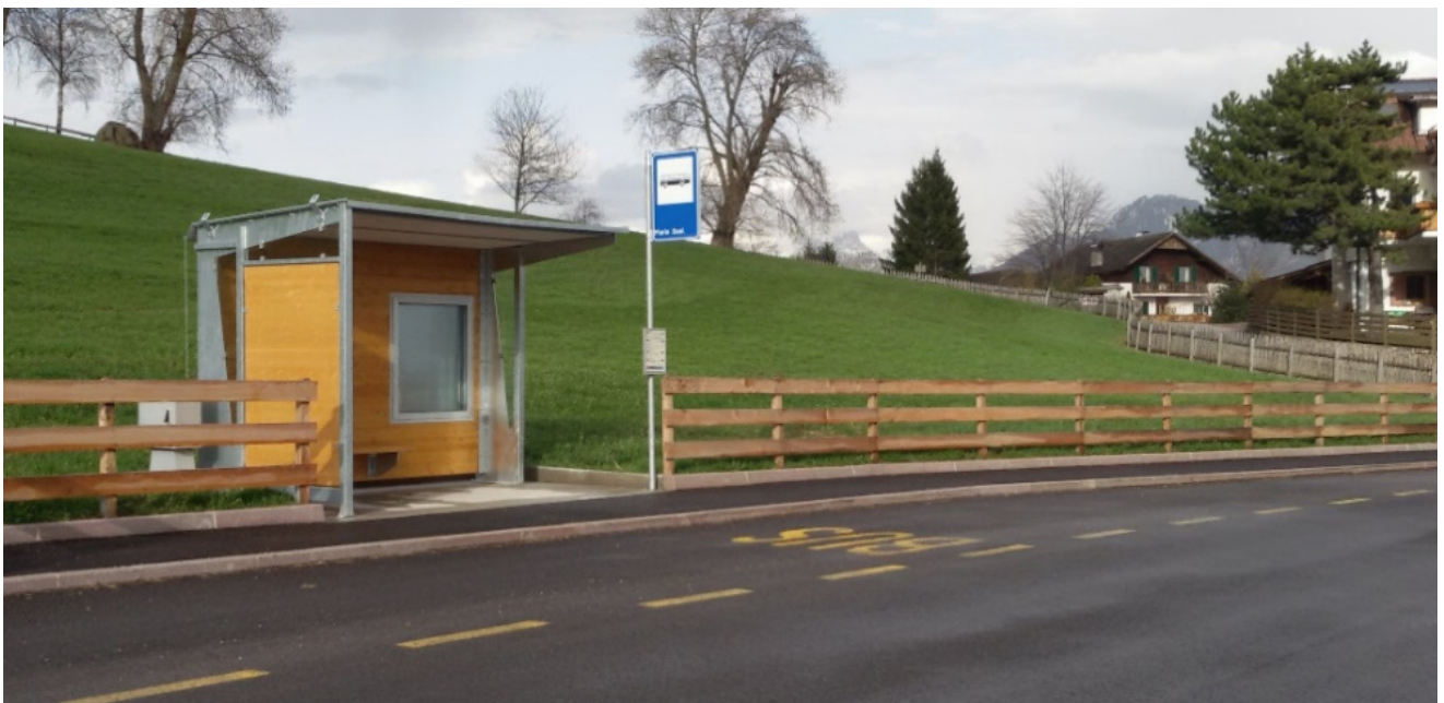
Bild A-6 Bushaltestelle mit erhöhtem Wartebereich
