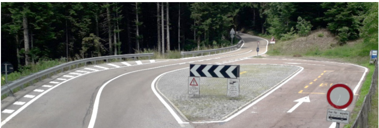
Bild B-8 Buswendebereich Fig. B-8 Area di svolta bus
