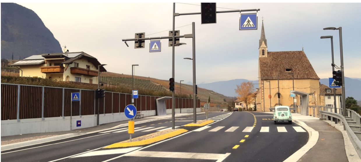
Bild A-5 Haltestelle außerhalb der Fahrbahn und Fußgängerübergang
