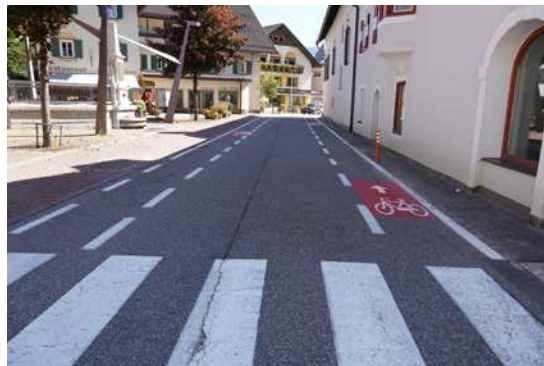
Radfahrstreifen auf Straße mit/ohne Mittellinie / Corsie ciclabili su strada con/senza striscia di mezzzeria
