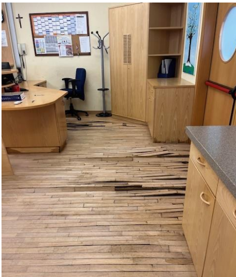
I danni alla pavimentazione della sala ricevimento
