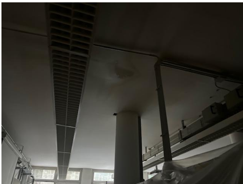
Il laboratorio Elettrico e Elettronico con il controsoffitto intriso d'acqua e il pavimento in legno danneggiato dall'umidità
