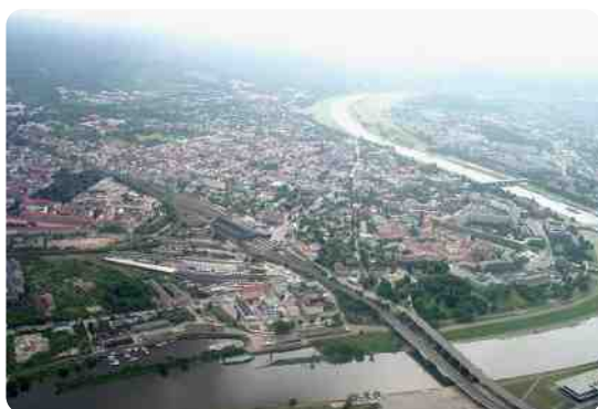
Valle dell'Elba e ponte "Waldschlösschen" (Germania)
