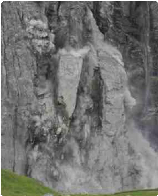
Felssturz an der Eiger-Ostwand (Schweiz), Juli 2006
