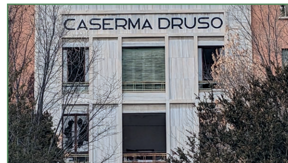
La facciata attuale dell'ex caserma Druso
