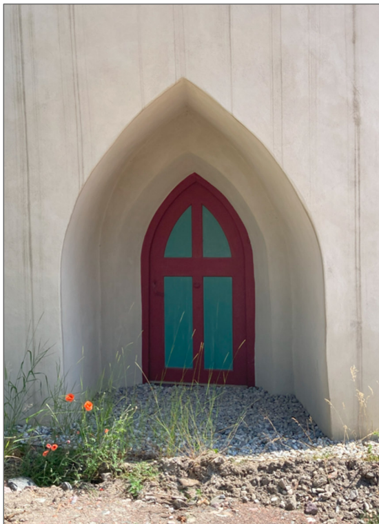
Foto 03 Eingangstür Erdgeschoss | Porta d'ingresso del piano terra
