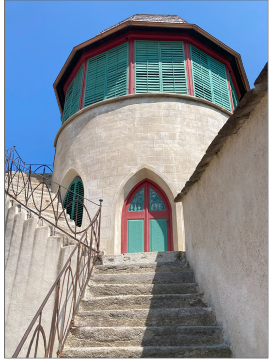
Foto 02 Ansicht Ost | Prospetto est
