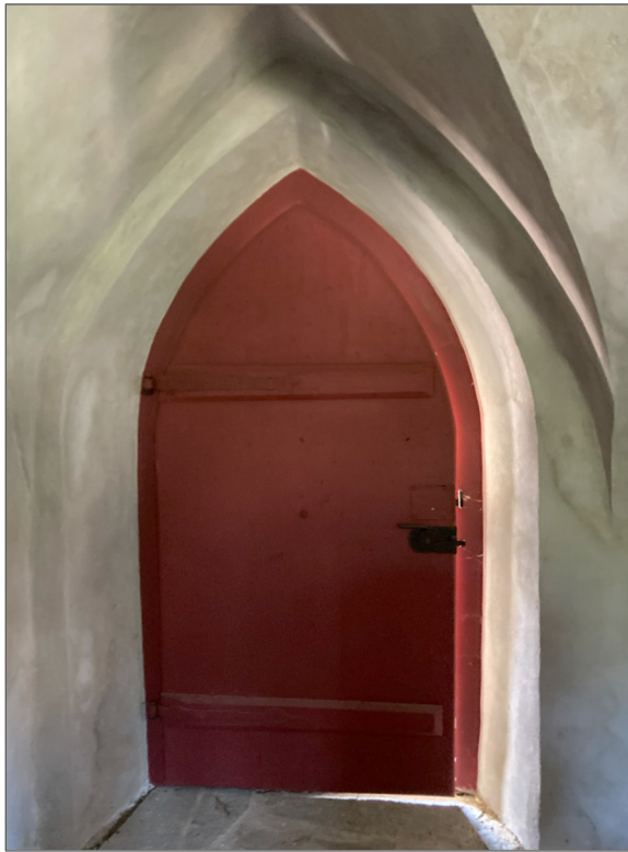
Foto 13 Eingangstür EG von innen | Vista d'interno della porta d'entrata del piano terra
