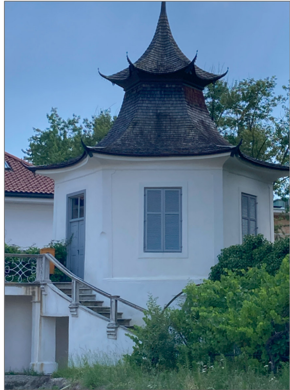
Foto 24 Ansicht Nord | Prospetto nord
