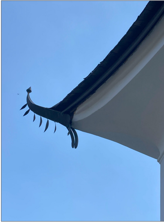
Foto 27 Dachdetail Ornament | Particolare tetto con ornamento
