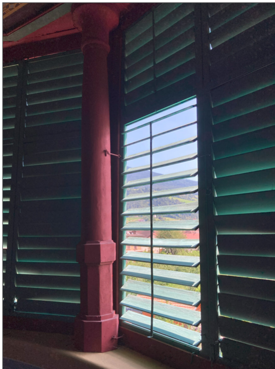
Foto 07 Fensterläden 2. OG | Persiane 2° piano
