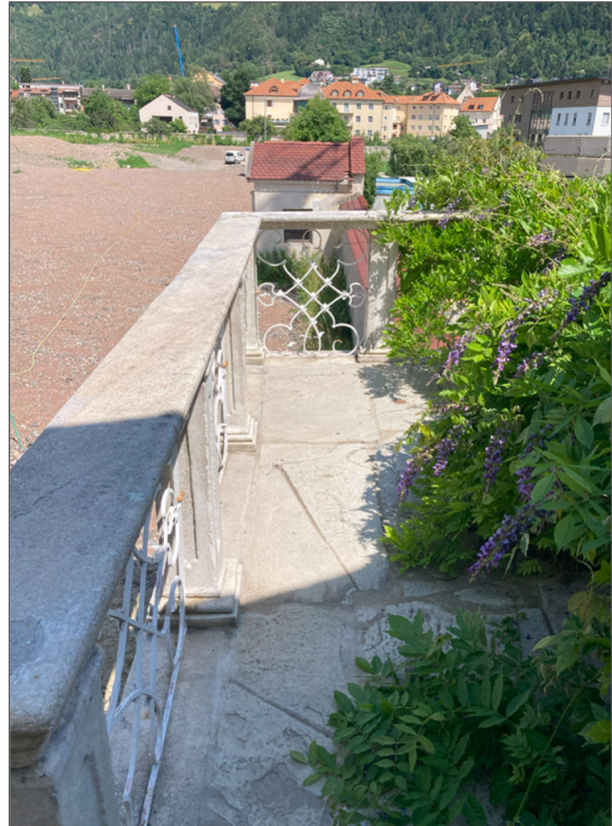
Foto 32 Blick nach Osten auf die Terrasse im Osten | Vista verso est sul terrazzo
