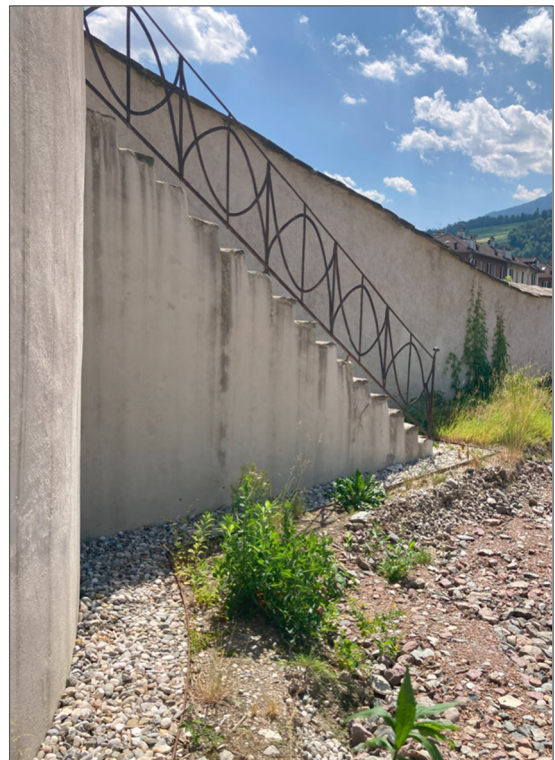
Foto 04 Treppe – Ansicht Südwest | Scala – prospetto sudovest
