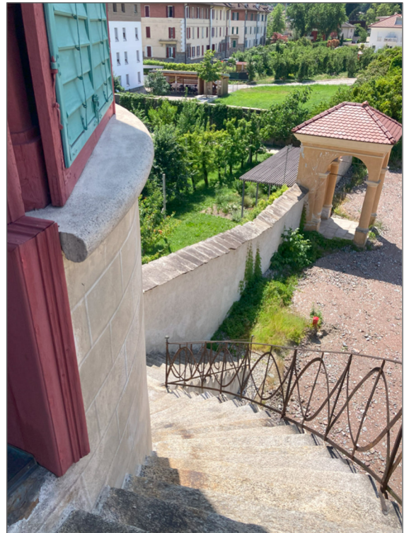
Foto 06 Blick vom 2. OG nach unten auf die Stiege | Vista dal 2° piano sulla scala
