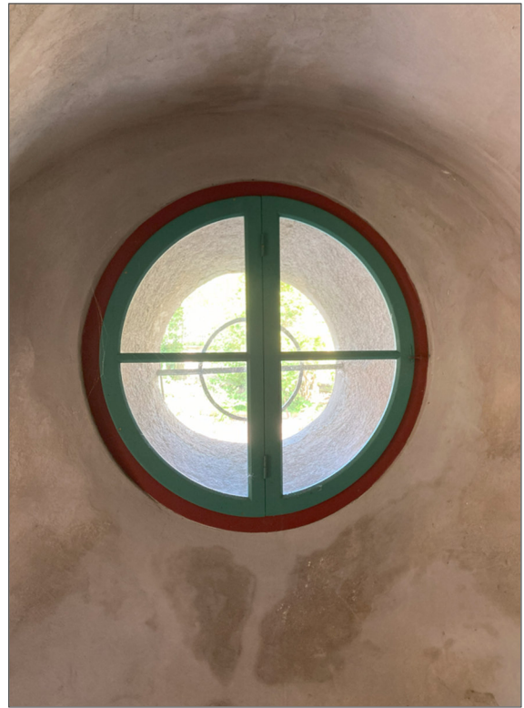
Foto 14 Fensteröffnung Erdgeschoss | Finestra del piano terra
