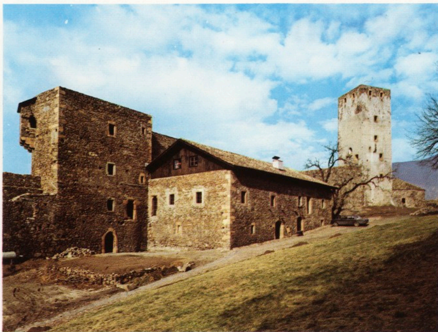
Mura e torri di Castel Firmiano (Bolzano). Sono stati risanati grazie all'intervento provinciale, gli interni dall'amministrazione Toggenburg.
