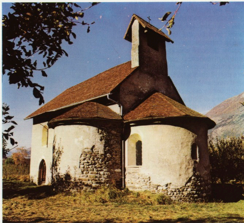
A Morter/Laces è stata ricoperta con scandole in legno la quasi millenaria chiesetta di S. Vigilio.
