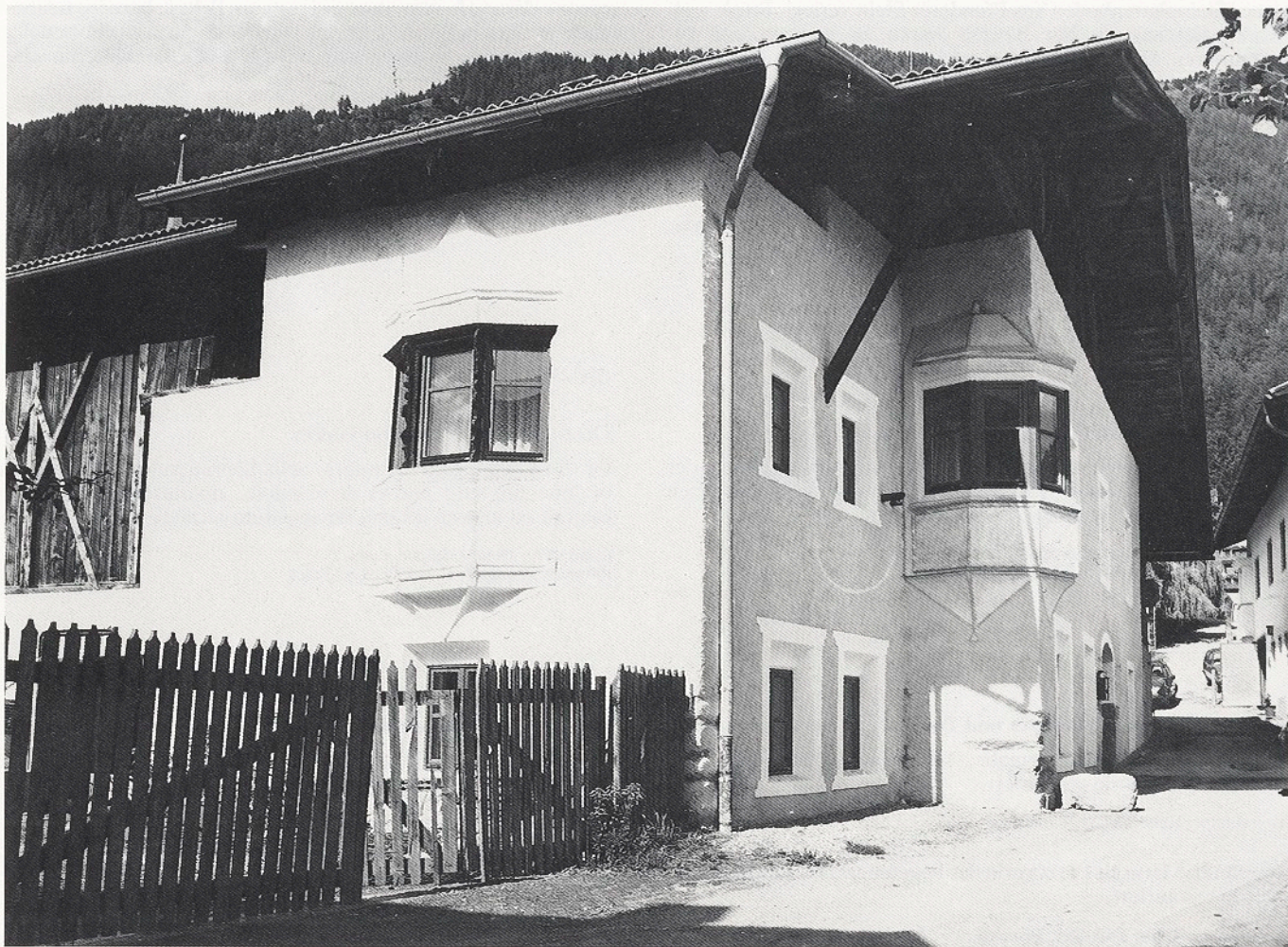
Trens, Guggeshof nach der Restaurierung Trens, maso Gugges dopo il restauro
