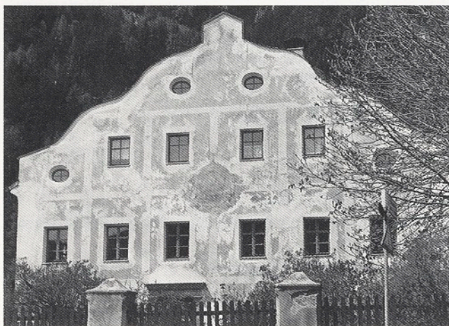
Gais, Pflegerhaus, Fassade vor und nach der Restaurierung Gais, casa del magistrato, facciata prima e dopo il restauro
