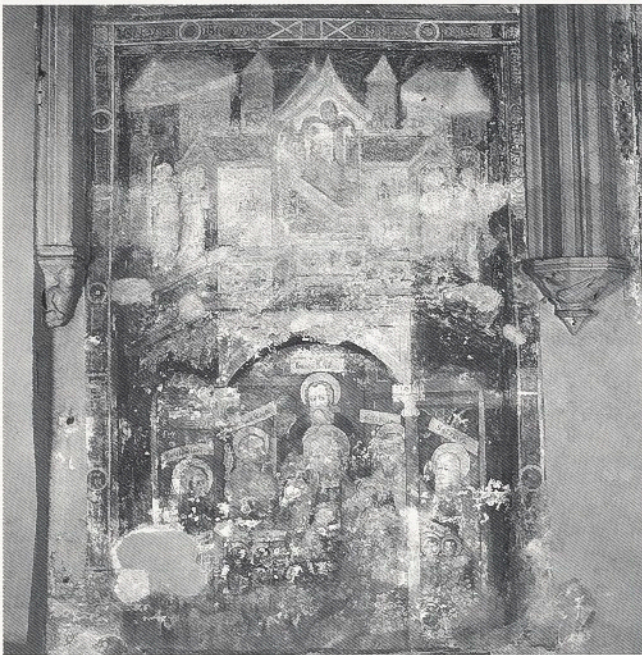
Die gleiche Szene um 1985: Feuchtigkeit und Salzausblühungen haben starke Verluste verursacht.
