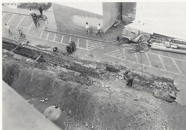
Bozen. Dominikanerplatz. Im Suchgraben ist ein Abschnitt der Klosterumfassungsmauer sichtbar. Von Osten.
