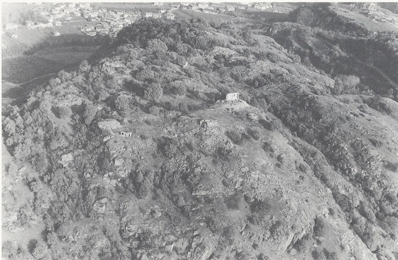
Montan. Castelfeder. Luftaufnahme des Hügels, von Süden aus gesehen. Die Pfeile zeigen auf die „Kuchelen“. Montagna. Castelfeder. Fotografia aerea del colle, da sud. Le frecce indicano i «Kuchelen».
