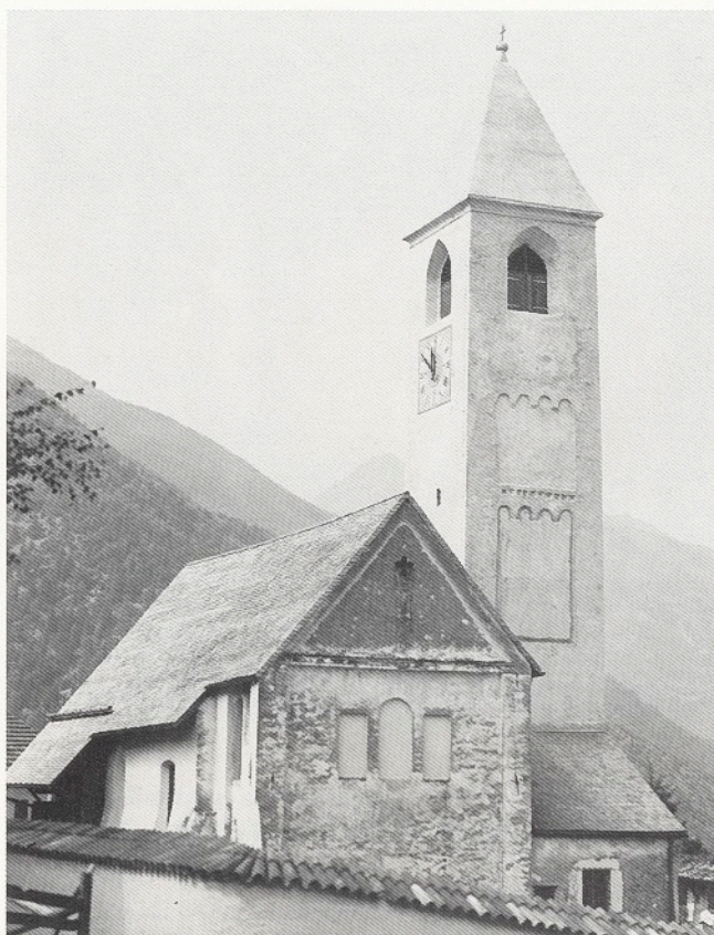
Latsch-Tarsch, Pfarrkirche St. Michael, Turm nach der Restaurierung Laces-Tarres, chiesa parrocchiale di S. Michele, campanile dopo il restauro
