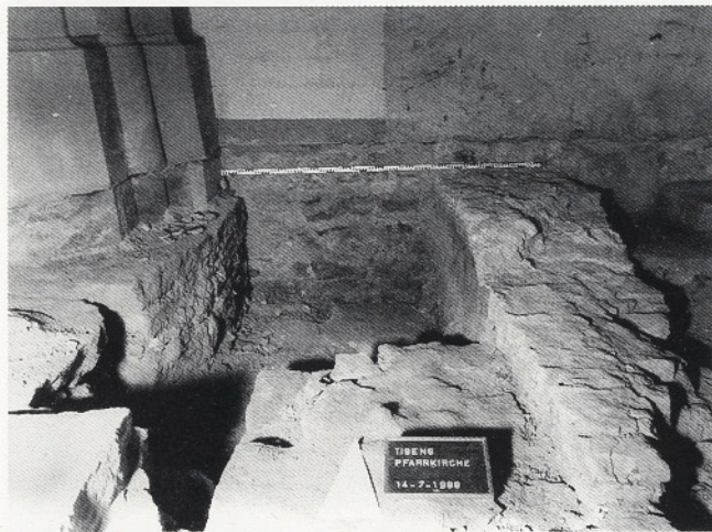
Abb. 15: Pfarrkirche Tisens. Blick auf die Nordmauer (12. Jahrhundert) und Mauer 2 (rechts im Bild) der frühgotischen Baumaßnahme. Vorne der anstoßende Altar. Die Estriche dieser Kirche liegen einen Meter unter dem heutigen Kirchenboden.
