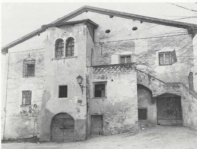
Kurtatsch, Ansitz Freienfeld vor und nach der Restaurierung Cortaccia, residenza Freienfeld prima e dopo il restauro
