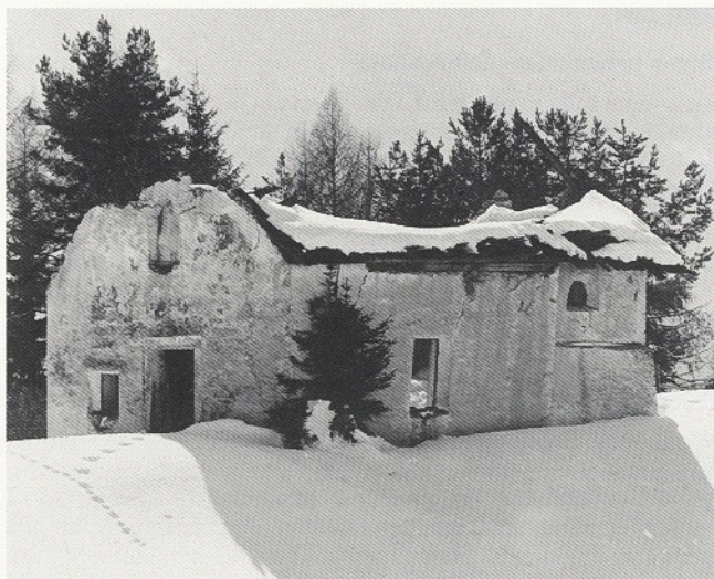
Terenten, Kapelle beim Moar am Gruben vor der Restaurierung und während der Einwölbung
