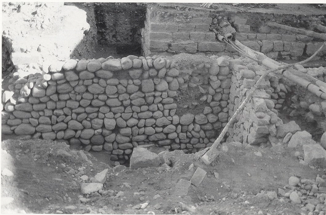
Bozen. Kornplatz. Reste des Turmes und der vermutlichen Grabenmauer. Bolzano. Piazza del Grano. Resti della torre e del probabile muro di riva del fossato.
