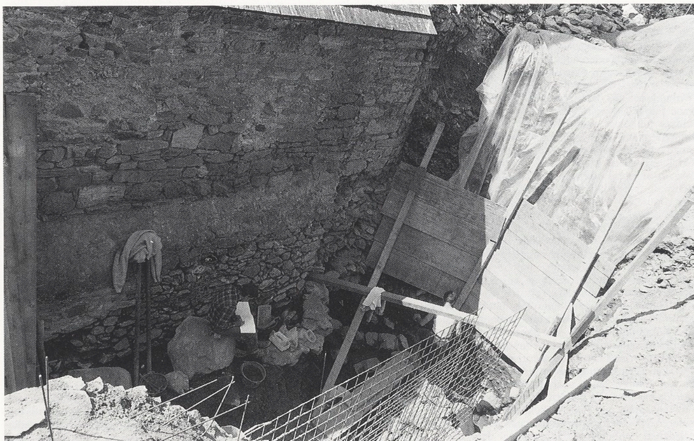
Schlanders. Kortsch. St. Laurentius. Die Ausgrabung auf der Nordseite des Kirchenschiffes. Silandro. Corces. San Lorenzo. Scavo all'esterno dal lato settentrionale della navata.
