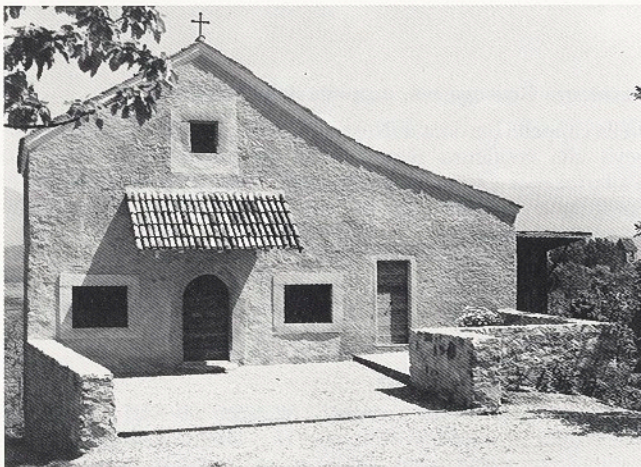
Eppan, Katharinenkapelle nach der Restaurierung Appiano, cappella di S. Caterina
