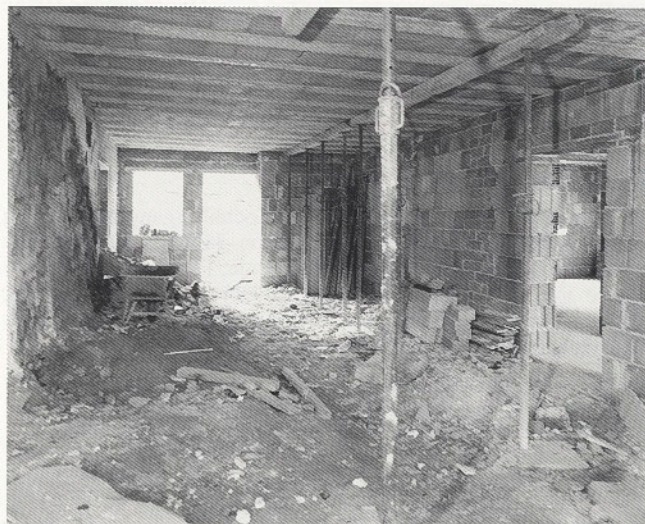
Labe nach der Zerstörung des Gewölbes corridoio dopo la demolizione dell'avvolto
