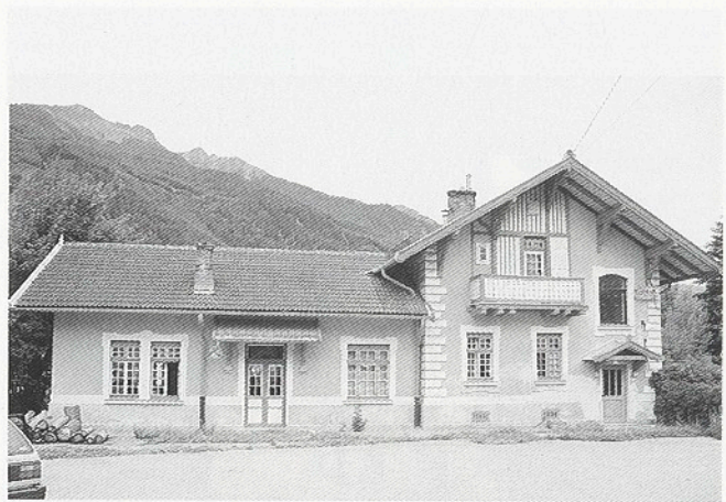
Vinschger Bahn, Bahnhofsgebäude der Station Laas Ferrovia Merano-Malles, stazione di Lasa
