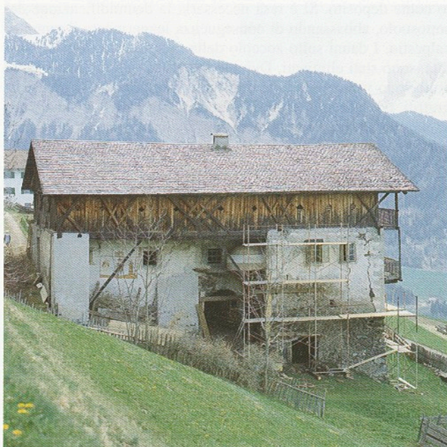
Villnöß, Felthun, während der Sanierung Funes, Felthun, durante il risanamento
