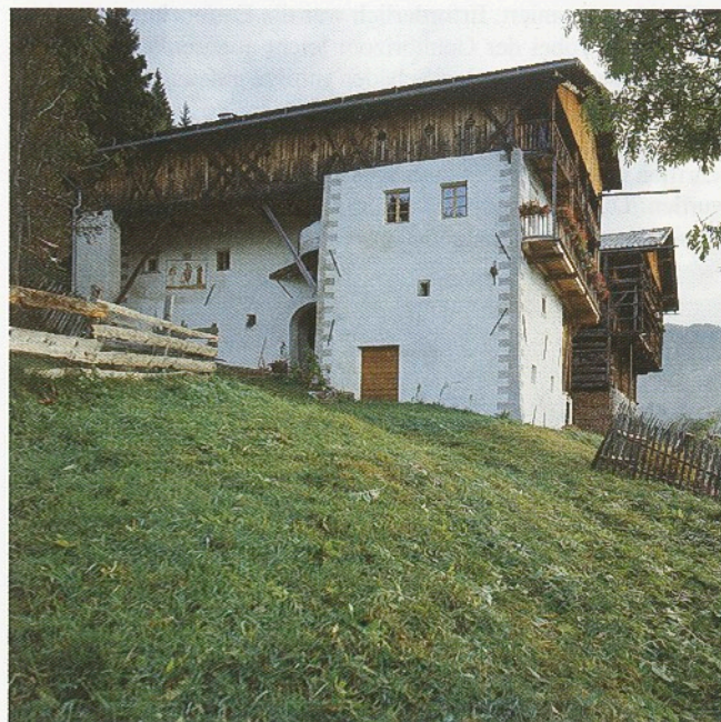
Villnöß, Felthun, nach der Sanierung Funes, Felthun, dopo il risanamento
