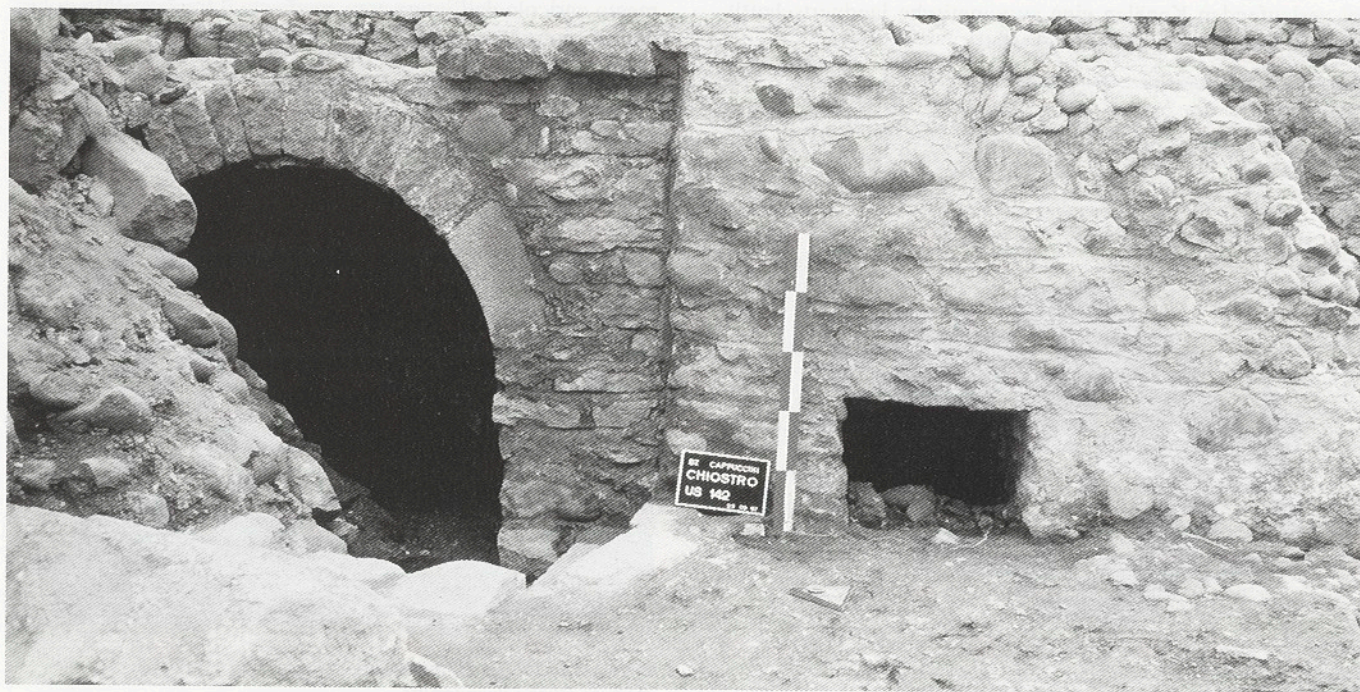
Bozen, Kapuzinerkloster. Romanische Mauern
