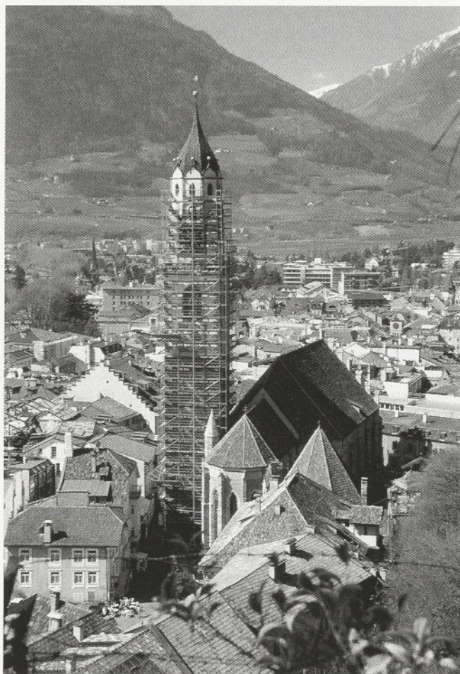
Meran, Pfarrkirche St. Nikolaus, während der Restaurierung des Turmes
