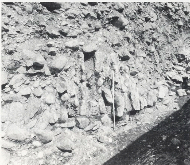
Fig. 13: Troncone di muro XIII, reclinato in direzione Sud.
