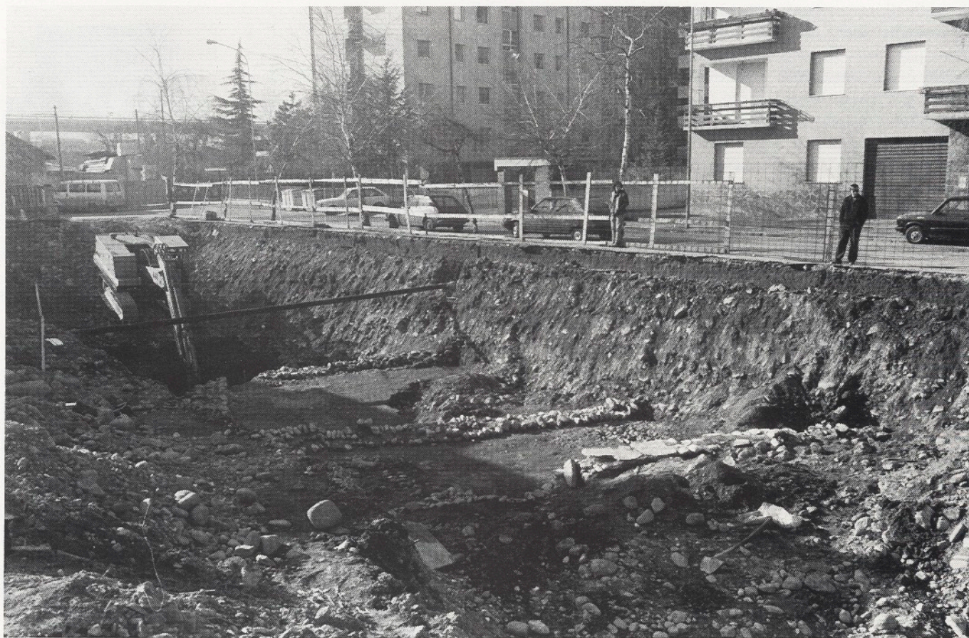
Fig. 3: Ala Sudovest dell'ambulacro (ambiente A) e locale della cisterna (ambiente B). Da Nord.
