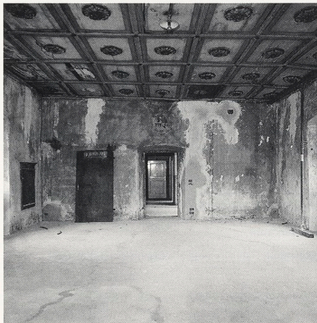
Bozen, Saal im Gutshof Mariaheim vor und nach der Restaurierung. Bolzano, sala nella tenuta Mariaheim prima e dopo il restauro.
