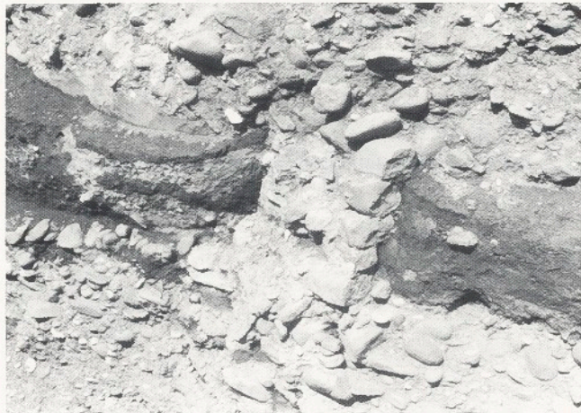
Fig. 10: Muro XIV tra ambulacro (ala Sud Ovest) e giardino del chiostro.
