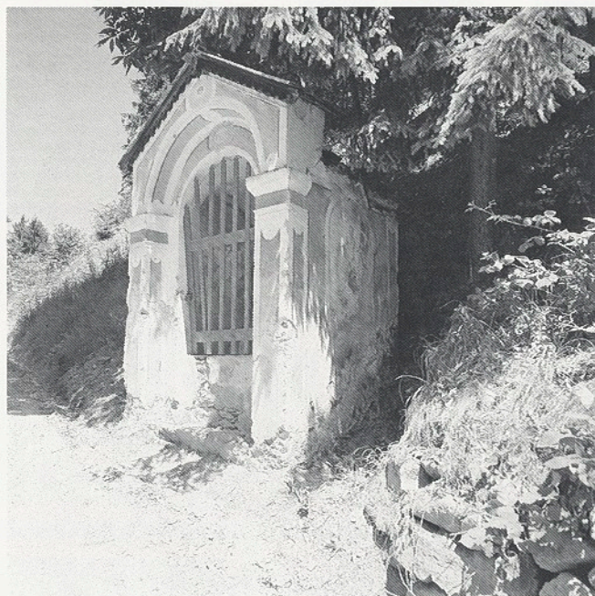
St. Leonhard in Passeier-Schweinsteg, Waldkapelle vor und nach der Restaurierung.
