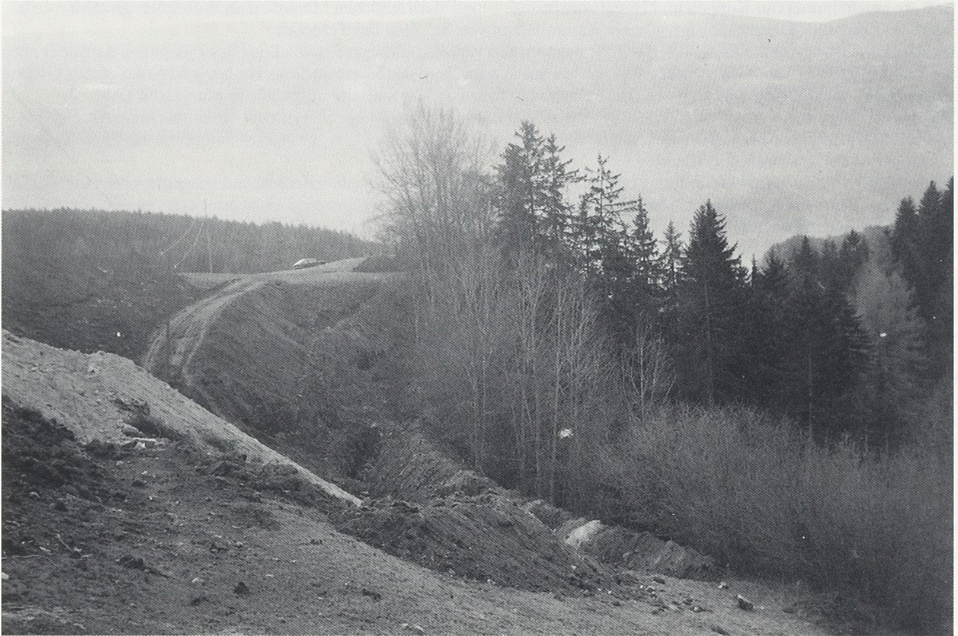
Abb. 2 Terenten-Zienleite. Ansicht des Baggergrabens von Norden.
