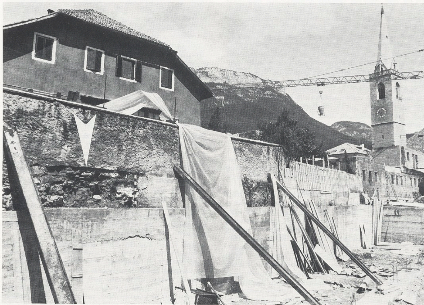
Kaltern. Goldgasse. Reste des römerzeitlichen Gebäudes. Caldaro. Via d'Oro. Tracce dell'edificio di età romana.
