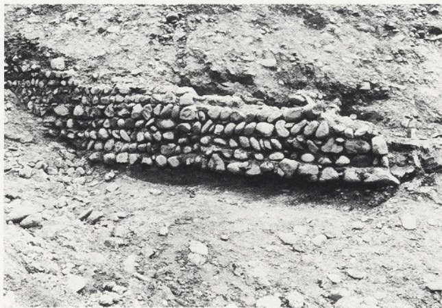
Fig. 6: Muro n. 8. Ambulacro ala Nord Ovest.
