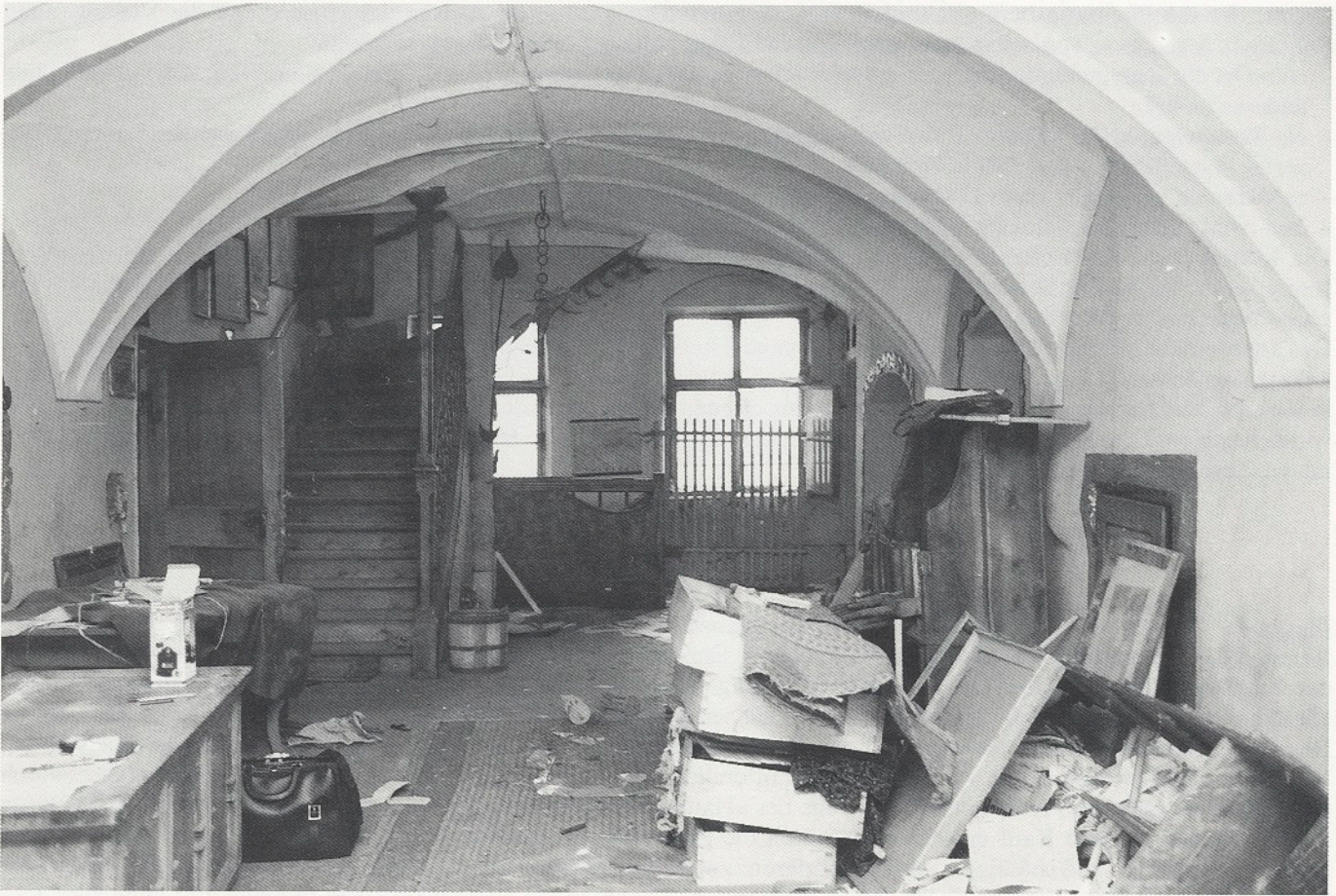
Niederdorf, Haus Wassermann.
