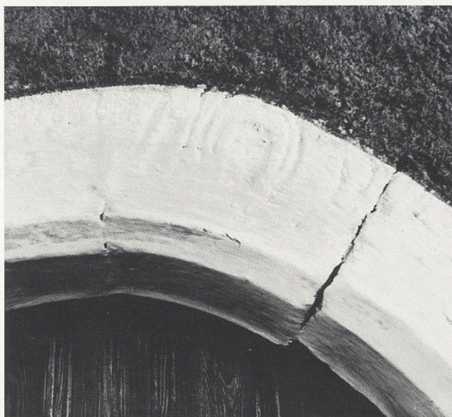
18. Eingang zur Schmiede beim Großackerer in Unterinn (Detail)
