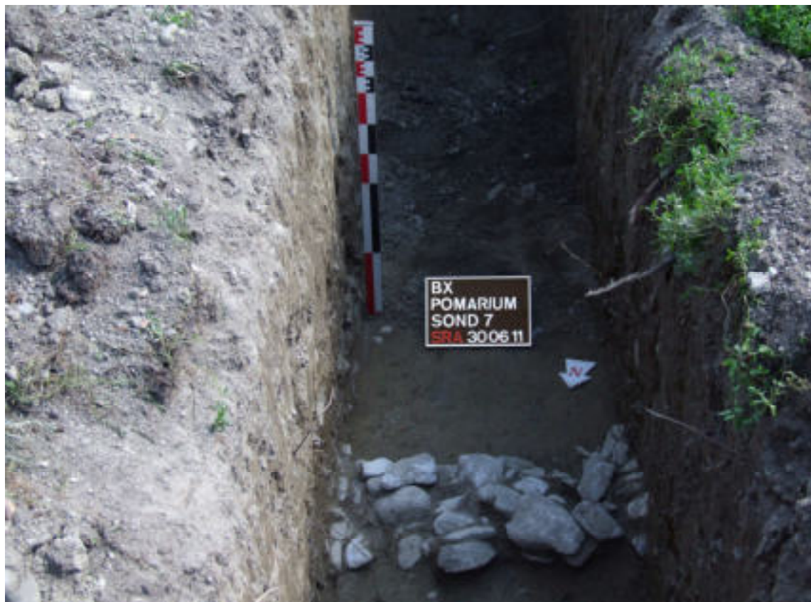
Abb. 16: Profil 7, Detail der Mauer, leider in einem schlechten Zustand
