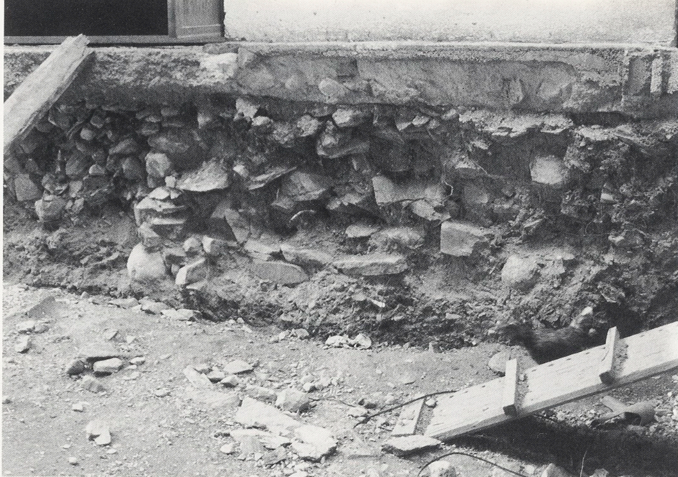
Gufidaun, Gschlosserhof. Unter dem Fußboden des heutigen Heustadels die Spuren (Grundmauern, Versturzschiicht usw.) des römzeitlichen Gebäudes, die vom Bagger entzweigeschnitten wurden. Gudon, maso Gschlosser. Al di sotto del pavimento del fienile attuale le tracce (muri perimetrali, crollo) dell'edificio di Epoca Romana, sezionato dalle macchine escavatrici.
