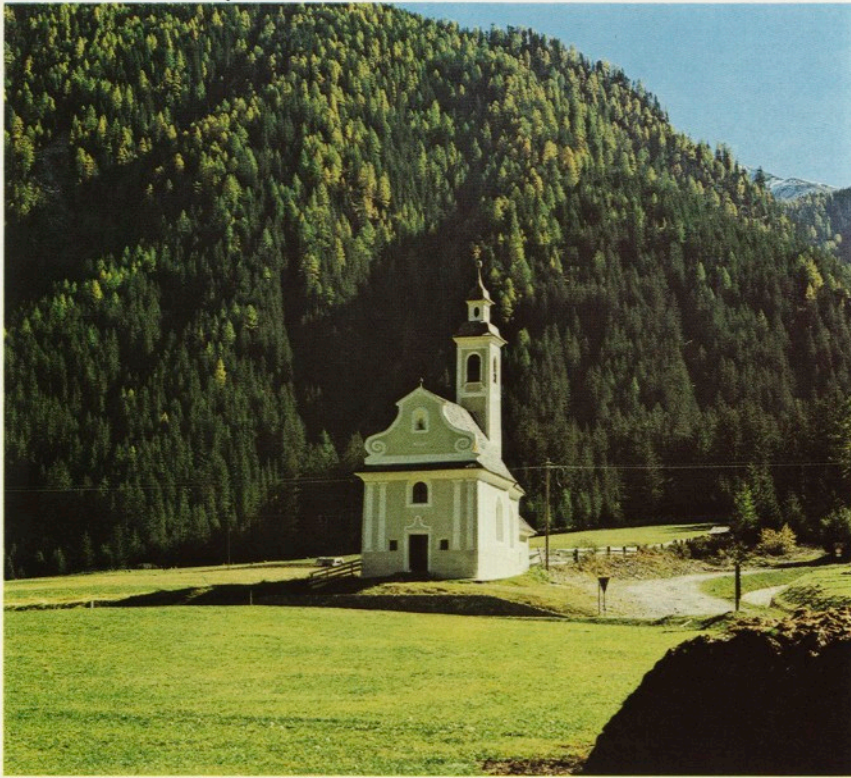
Gsies/St. Martin — Mairkapelle außen nach der Restaurierung.
