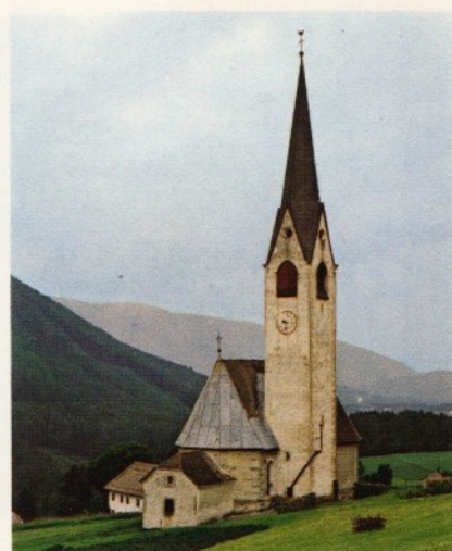
Percha/Nasen — St.-Jakob-Kirche außen vor der Restaurierung.
