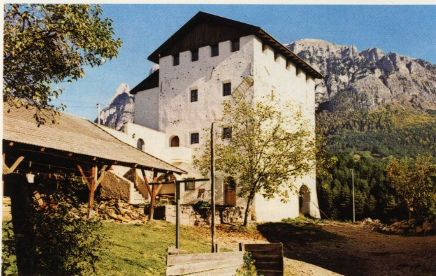
Völs — Ansicht Zimmerlehen, Wohnturm. Der Turm des malerischen Gebäudekomplexes, der immer Wohnzwecken diente, wurde vom Eigentümer saniert.
