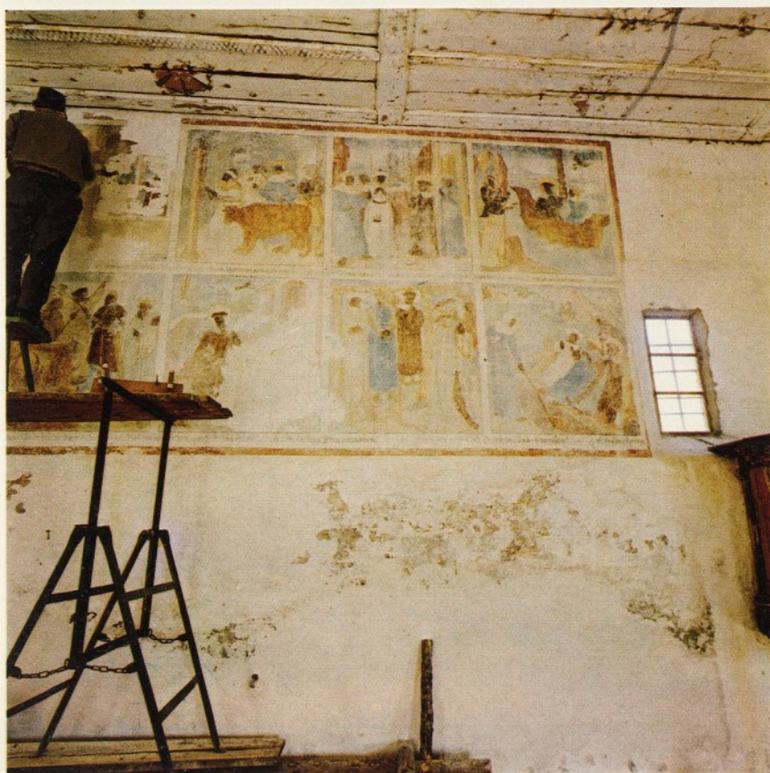
Tartsch/St. Veit am Bühel — Freilegung von Fresken (ca. 1520) und einer spätgotischen Balkendecke.
