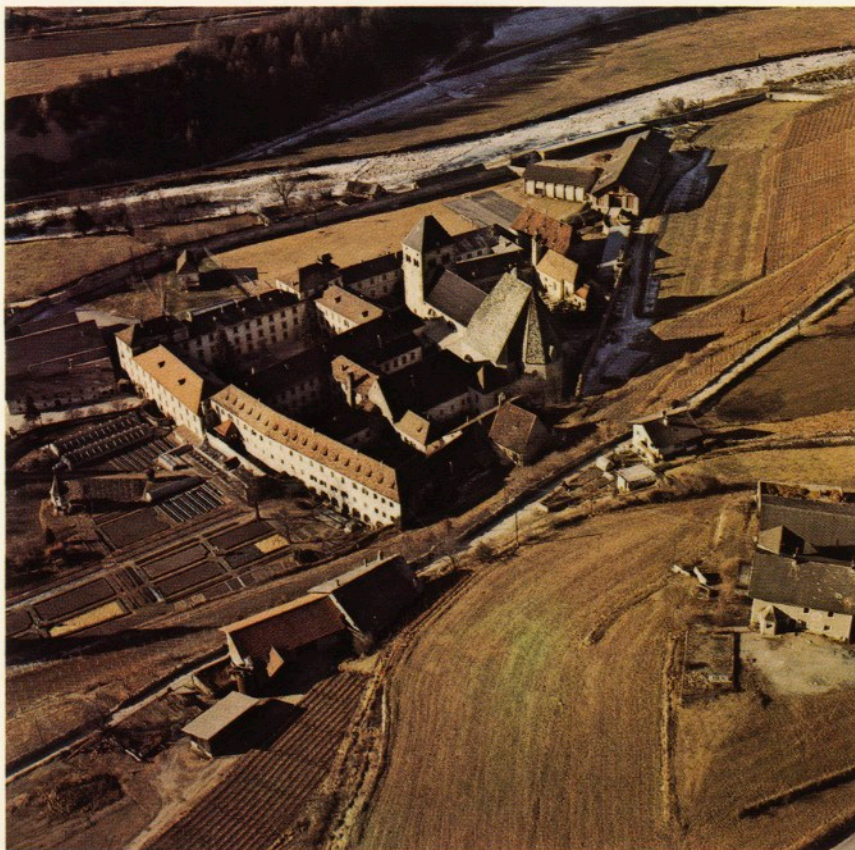
Kloster Neustift — Die Restaurierung des Stiftes stellt eines der größten Projekte in Südtirol dar. Die Dächer sind bereits erneuert worden, jetzt wird die Stiftskirche in Angriff genommen.
