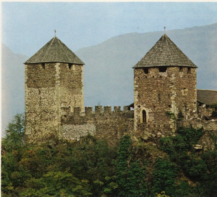
Lana — Leonburg. Einstürzende Umfassungsmauern wurden mit einem Beitrag des Denkmalamtes instand gesetzt.
