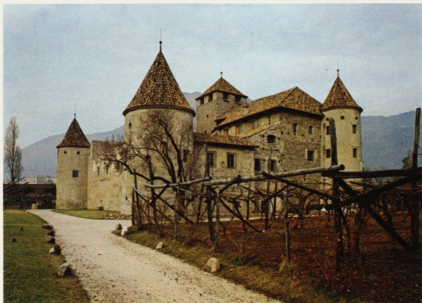
Bozen — Schloß Maretsch außen nach der Restaurierung. Die Kurverwaltung Bozen hat mit Unterstützung der Landesregierung und der Landessparkasse das Schloß grundlegend saniert, wobei auch viele Renaissance-malereien bloßgelegt wurden.
