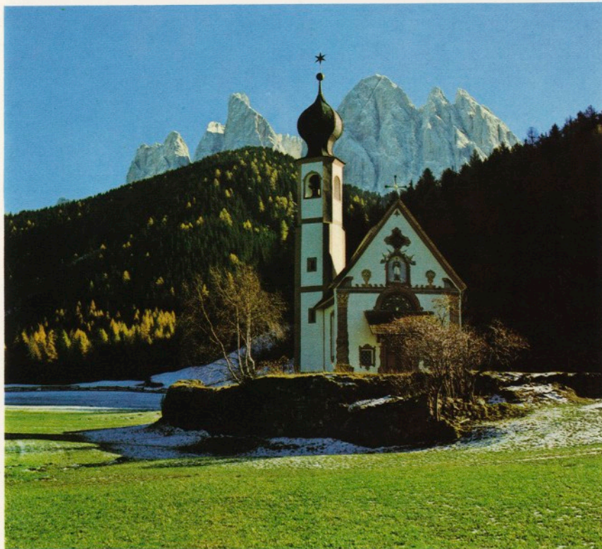
Villnöß/St. Magdalena — Ranuikapelle außen nach der Restaurierung. Die 1744 erbaute Barockkapelle wurde 1979 auf Kosten des Denkmalamtes außen und innen restauriert.
