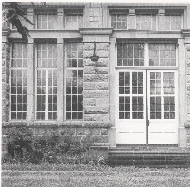
Dettaglio dell'ingresso principale sala motori
