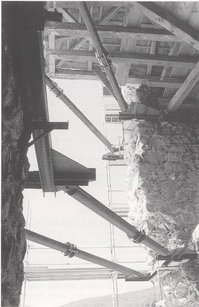
Abb. 3: Zunächst wurden die Bruchsteinflächen von losem Steinmaterial gesäubert und mit Spritzbeton gesichert. Erst anschließend konnte der Bergfried in verschiedenen Ebenen mit einem Stahlkorsett umgeben sowie das Arbeitsgerüst montiert werden. Im Bild die beiden obersten, gelenkig ausgebildeten inneren und äußeren Stahlkorsette unter dem Dachansatz.
