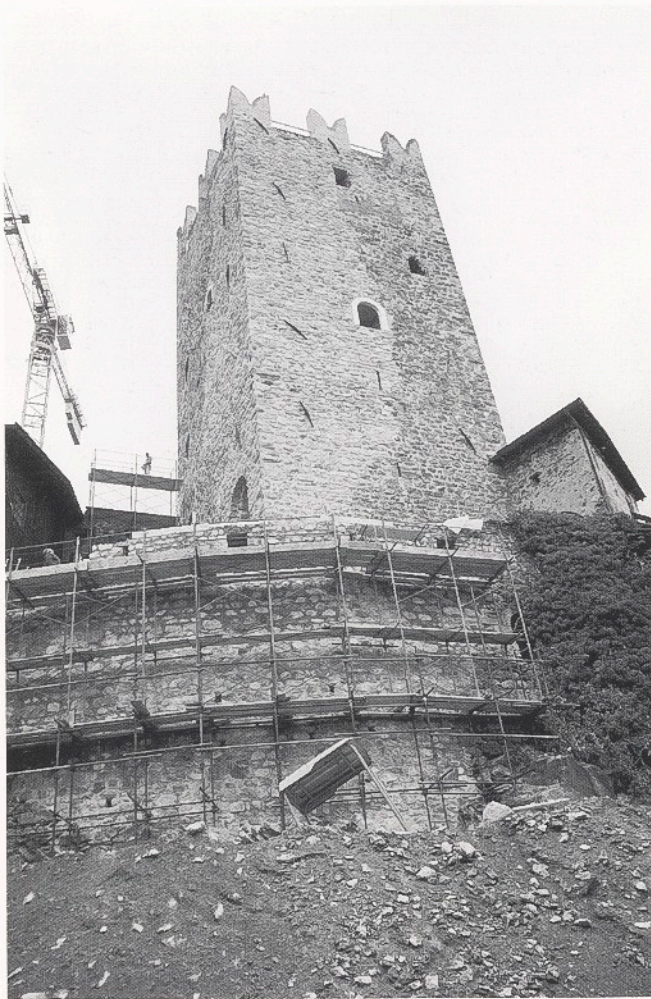
Abb. 7: Im Mai 1996 war der Wiederaufbau der inneren Wehrmauer weit fortgeschritten. Im Hintergrund der bereits ausgerüstete Bergfried. Die erneuerten Fassadenflächen heben sich vom Altbestand deutlich ab. Klar ersichtlich sind weiters die verschiedenen Zuganker, welche auf Bodenniveau der einzelnen Turmgeschosse eingezogen wurden.
