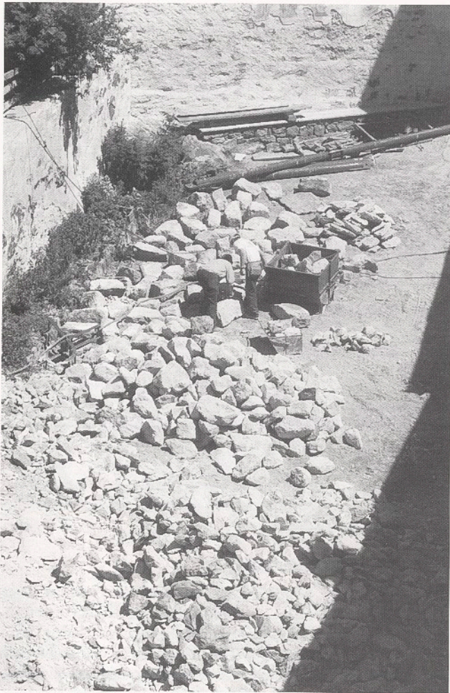
Abb. 5: Im Innenhof wurde das angefallene Steinmaterial auf mögliche Haarrisse untersucht und für den Wiederaufbau fein säuberlich aussortiert.
