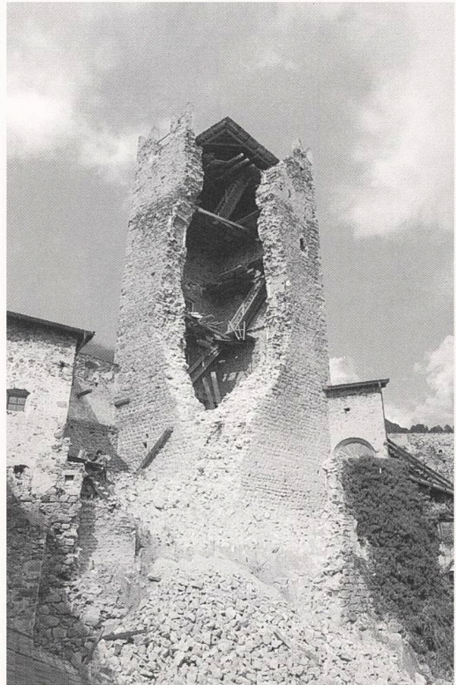
Abb. 1: Der Bergfried unmittelbar nach dem Teilabsturz vom 24. September 1994. Der V-förmige Ausbruch an der Südostecke ist deutlich sichtbar. Im Vordergrund die teilweise zerstörte innere Wehrmauer.
