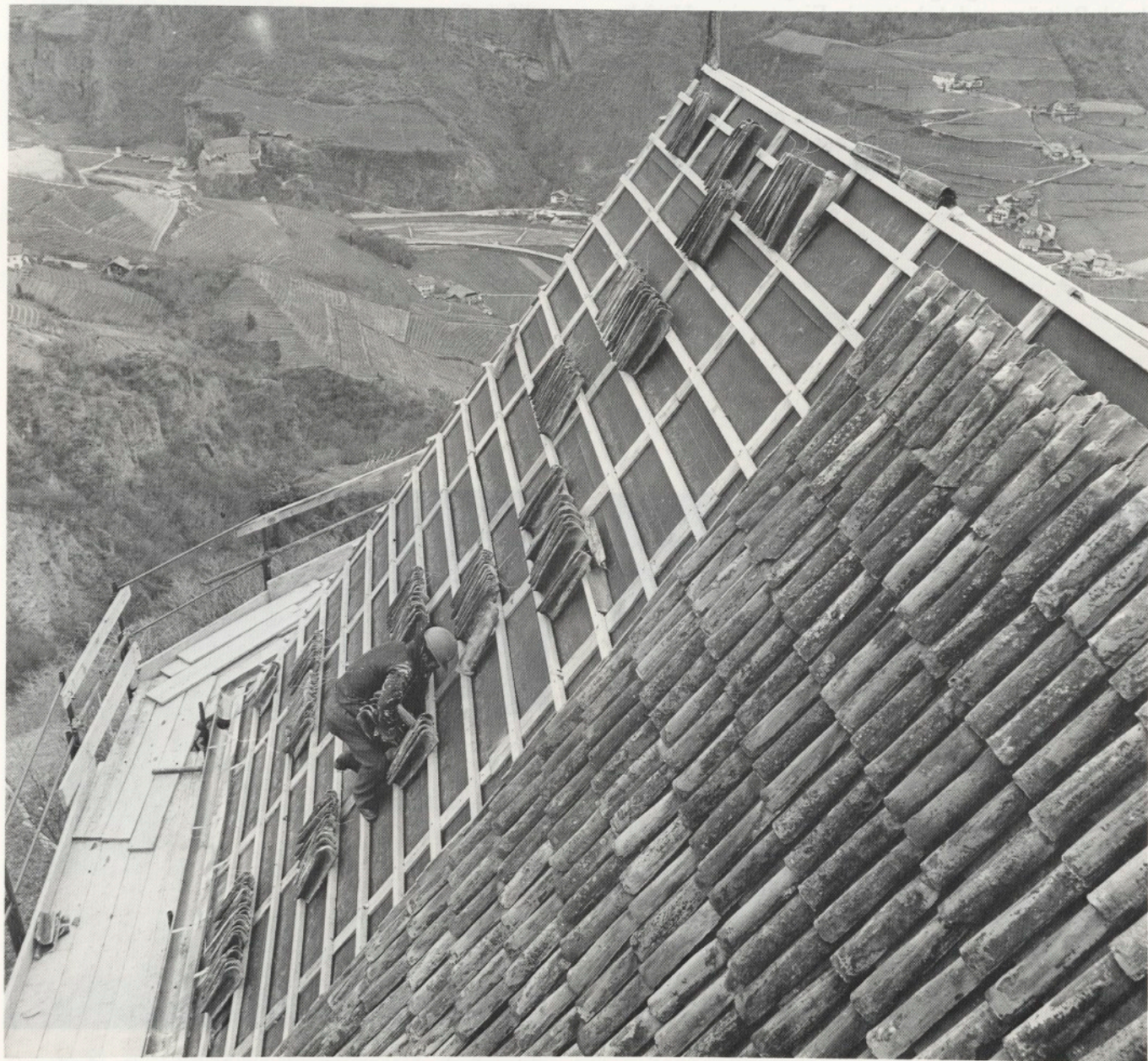
Neueindeckung von St. Georg am Kofel bei Bozen-Gries mit Hohlziegeln (Mönch und Nonne), die in kunstvoller Weise mit Kupferdrähten verankert werden. Fach- und materialgerechte Dachdeckung sind ein großes Anliegen der Denkmalpflege.
