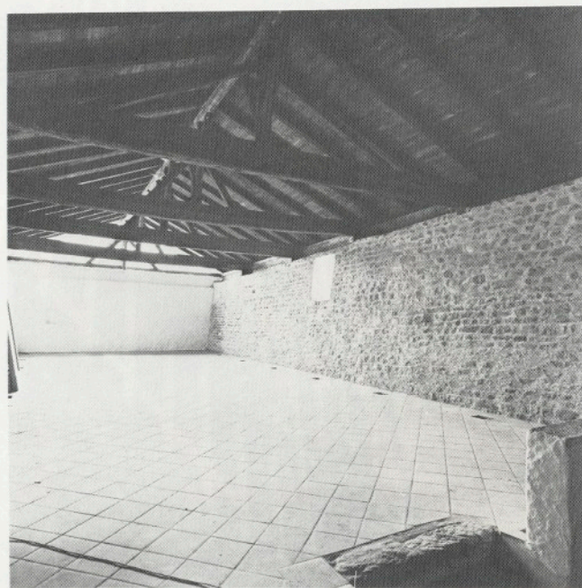
Castel Tirolo, la costruzione di servizio (già cucina, fienile etc.), prima e dopo i lavori di restauro. In tale edificio sarà allestita la sede del museo archeologico provinciale. Nelle costruzioni principali invece sarà aperta una mostra permanente dedicata alla storia del Tirolo.
