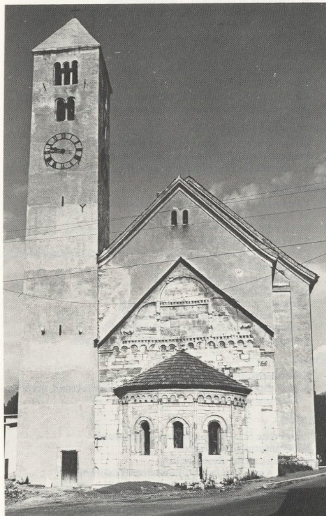
Il campanile di Lasa prima e dopo i lavori di restauro dell'anno 1983. Per restauro si intende riparare cautamente e non sostituire ex novo le strutture esistenti. In questo caso è stato recuperato l'originale tetto in muratura togliendo la copertura in coppi.
