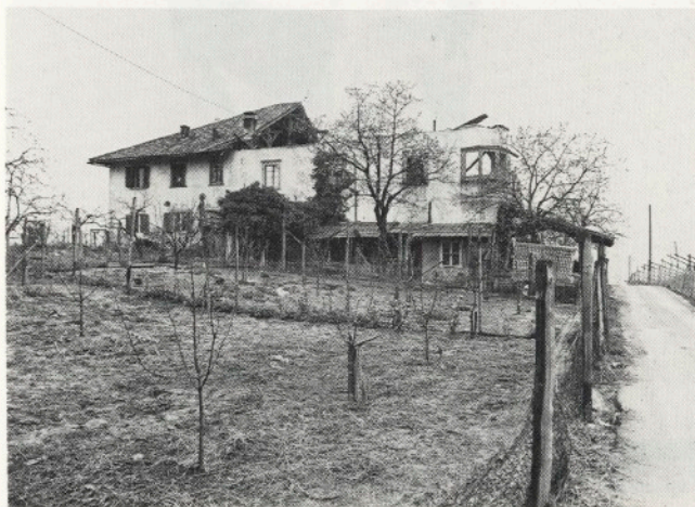
Der Renaissance-Ansitz Liebenstein in Eppan. Dieser kostbare Bau wurde durch Fahrlässigkeit seiner Besitzer zerstört. 1978 stürzte er nach langanhaltendem Regen, der die Fundamente unterspült hatte, ein.
