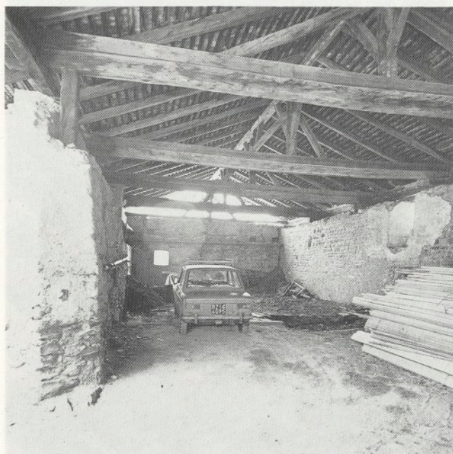
Schloß Tirol, Wirtschaftsgebäude, vor und nach Abschluß der Arbeiten. In den Wirtschaftsgebäuden soll das archäologische Landesmuseum seinen Sitz erhalten. In den Hauptgebäuden soll eine Dokumentation zur Geschichte des Landes Tirol aufgestellt werden.
