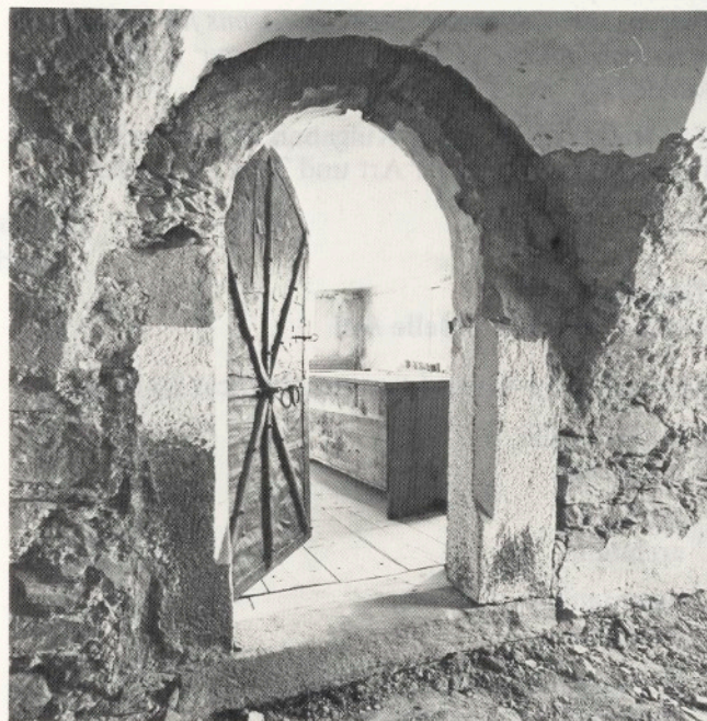
Barterhof in Kematen, Pfitsch. Gotische Tür vom Gang in die Kammer. Durch falsch verstandene Sanierungsmaßnahmen werden allzuleicht die alten Bauernhöfe abgerissen und durch Neubauten ersetzt.
