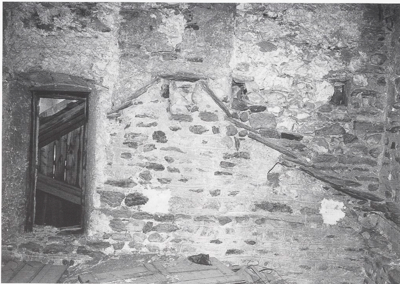
Sottotetto torre con la porta d'ingresso dal palazzo. Si notano le lastre della copertura romanica e la traccia dei merli.
