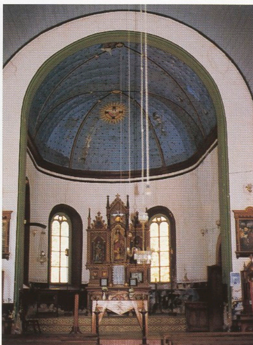
Ansichten der Kirche von Tirol in Espirito Santo/Brazilien vor (oben) und nach (unten) der Restaurierung. (Bericht S. 231 f.)
