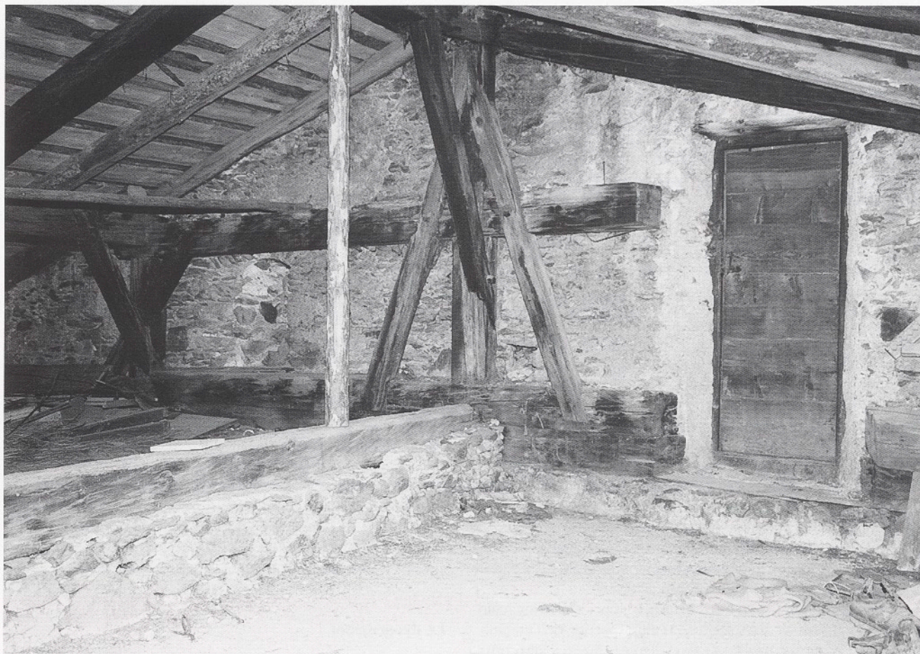
La struttura del tetto, si notano le travi segate per accedere alla torre piccola costruita nel XVII secolo.
