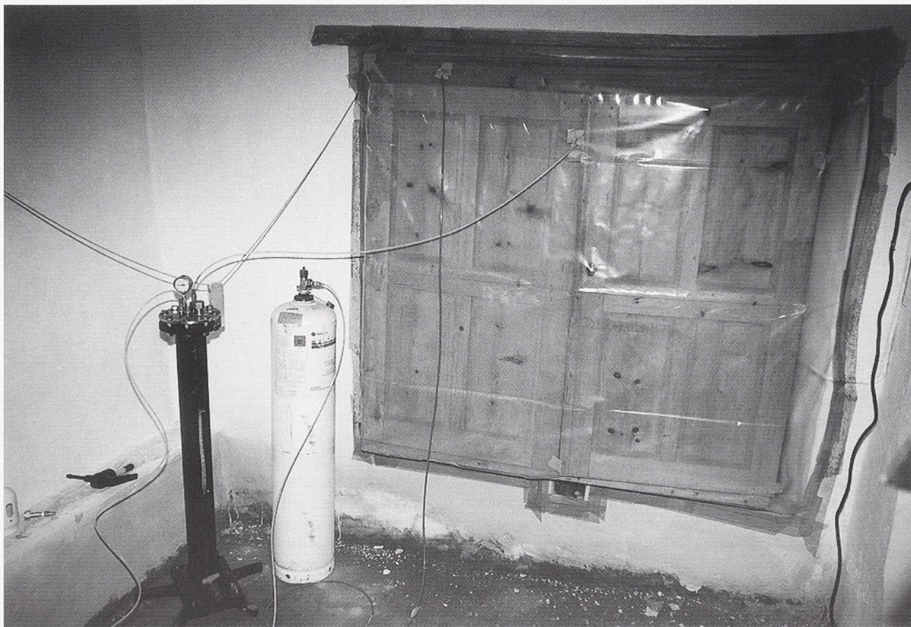
Goldrain, St. Anna in Schanzen: Der Einbauschrank in der Sakristei wurde mittels Gassperrfolie separat mitbegast.
