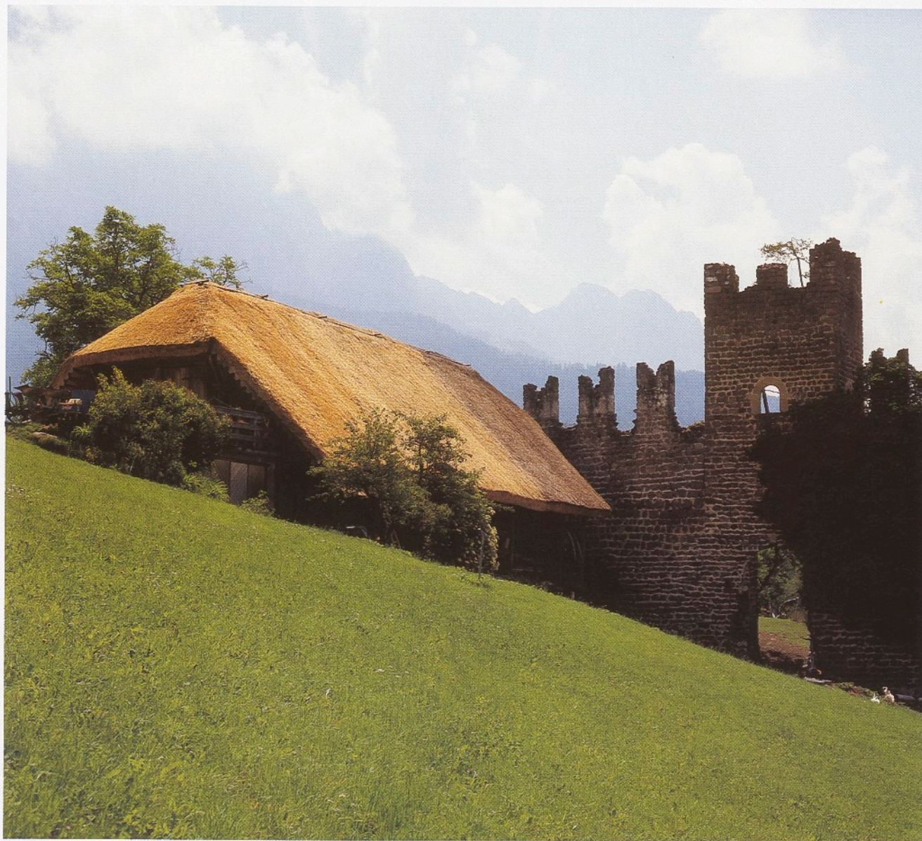
Kastelruth, Pfleger in St. Oswald: Wirtschaftsgebäude mit neuer Stroheckung. (Bericht S. 88) Castelrotto, Pfleger a Sant' Osvaldo: fienile con nuova copertura di paglia. (relazione p. 88)
