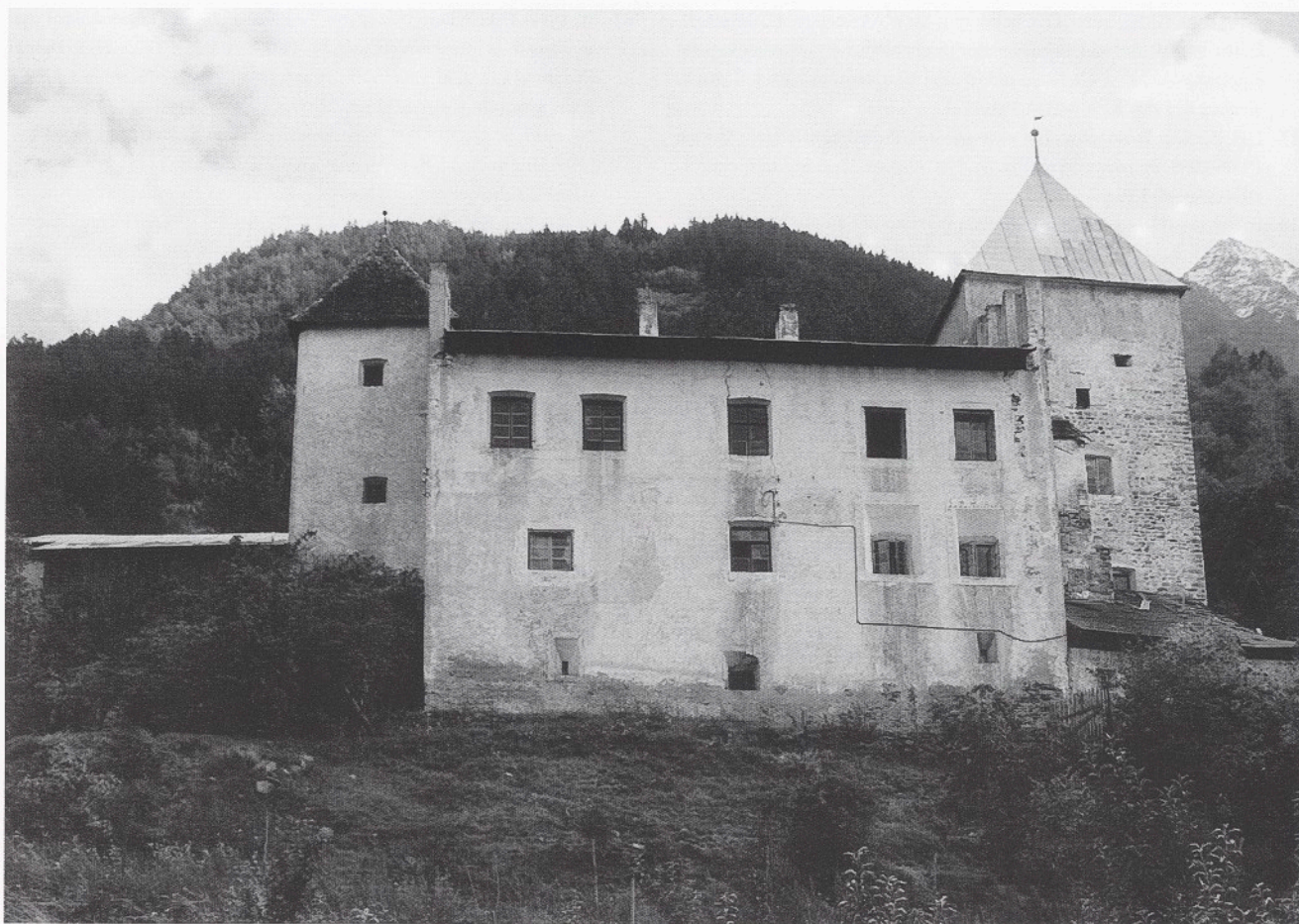
Castel Cengles, la facciata nordovest.
