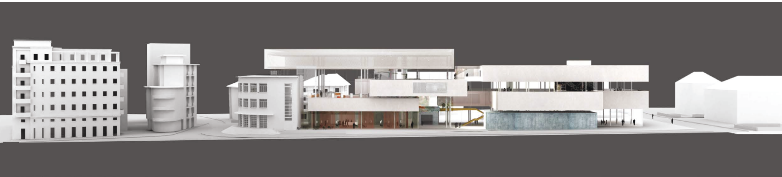
Alt und Neu: die drei Baukörper des Bibliothekszentrums. Rechts im Bild ist das derzeitige Gebäude der Landesbibliothek »Dr. Friedrich Teßmann« erkennbar. Foto: Christoph Mayr Fingerle
