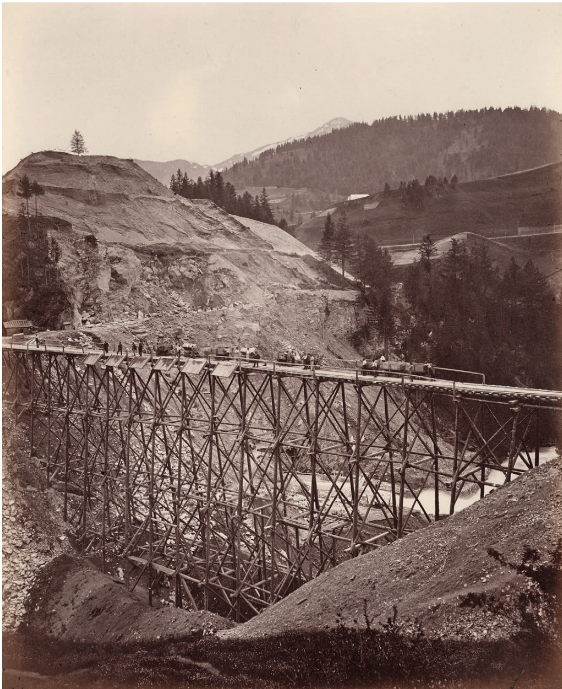
Eisenbahndammgerüst am Schlossberg von Mauterthaler am Brenner, Juni 1866
