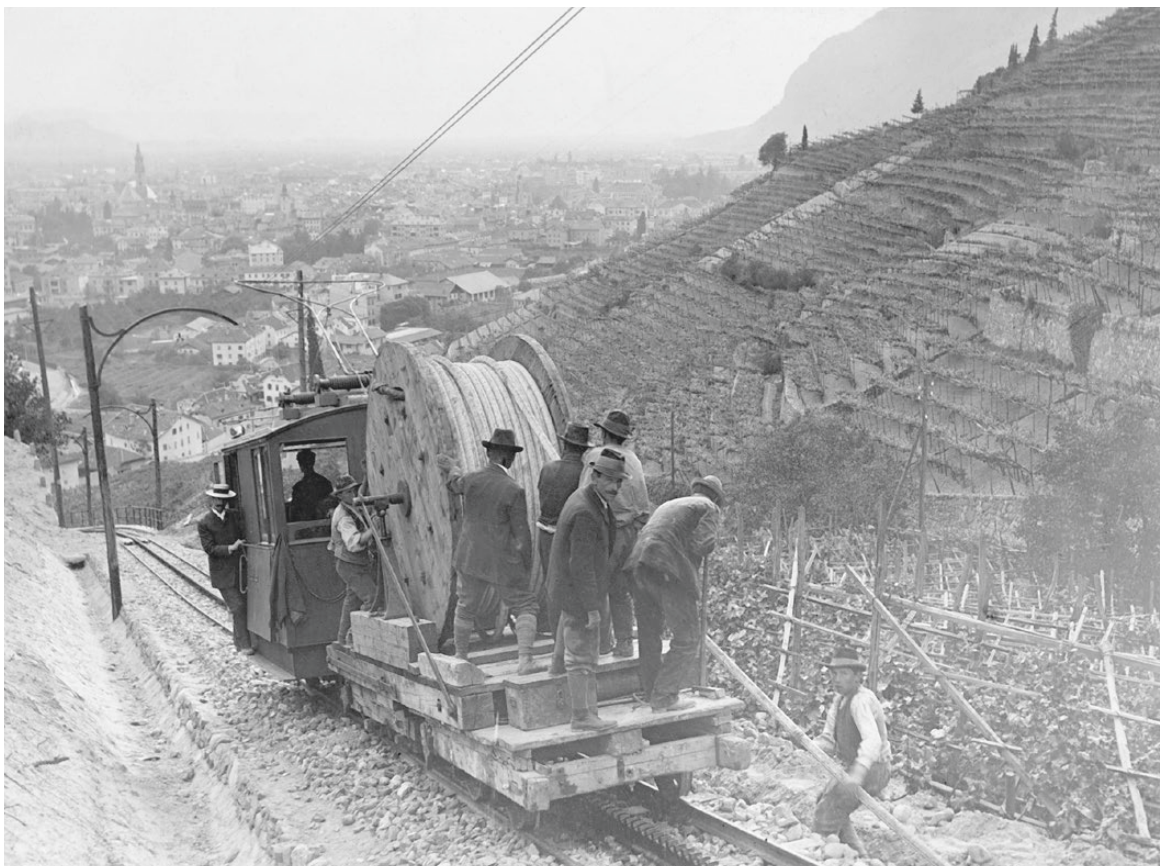
Posa dei cavi per la corrente lungo il percorso della cremagliera del Renon; Sognato, 1907;
