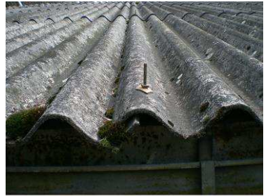
Tipica copertura in cemento amianto
