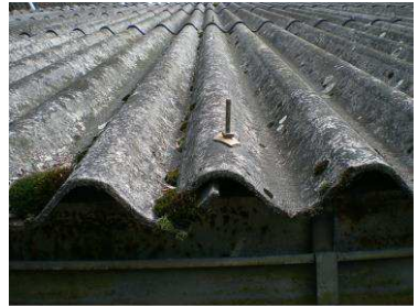
Tipica copertura in cemento amianto
