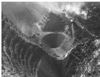
Der Steinbruch von Balangero in den 50er
