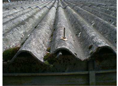
Typisches Asbestzement-Dach
