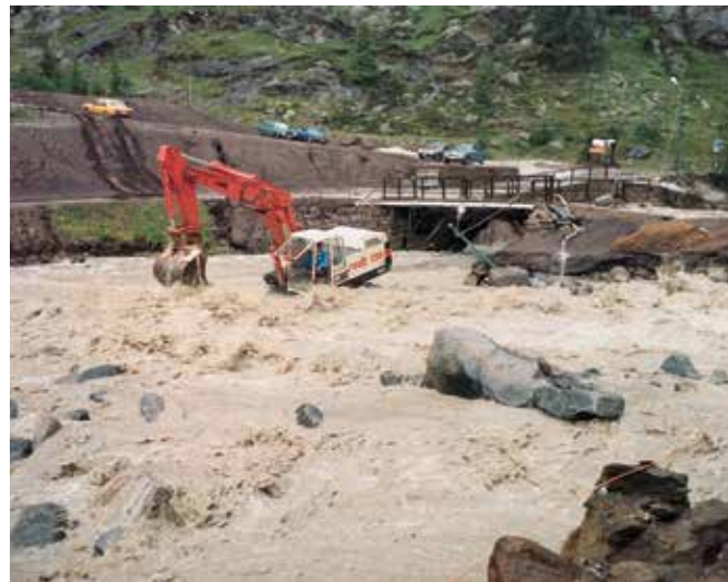
61. Pronto intervento a Masseria durante la piena del luglio 1987.
