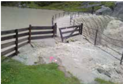
62. Überlauf an der Steinmauer in Aglsboden am 13. August 2014.
