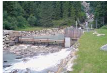
63. Wasserfassung des E-Werks am Fernerbach.
