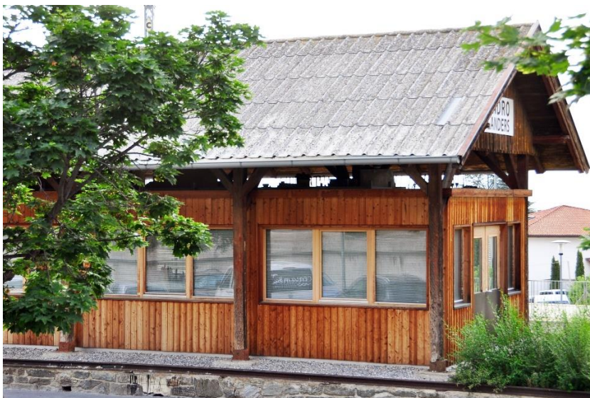
Abbildung 6 Detailansicht eingeschobene Holzkonstruktion
