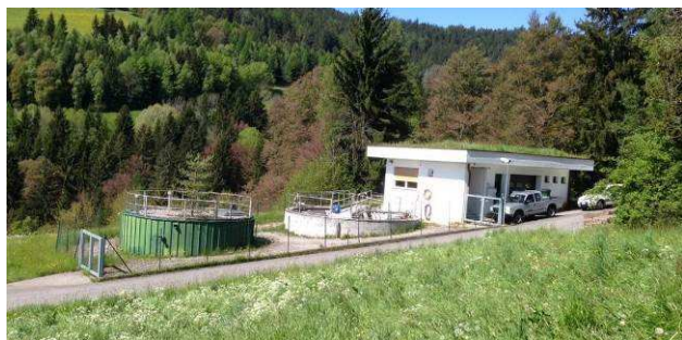
Ansicht der Anlage, Flaas (Foto: Amt für Gewässerschutz)
