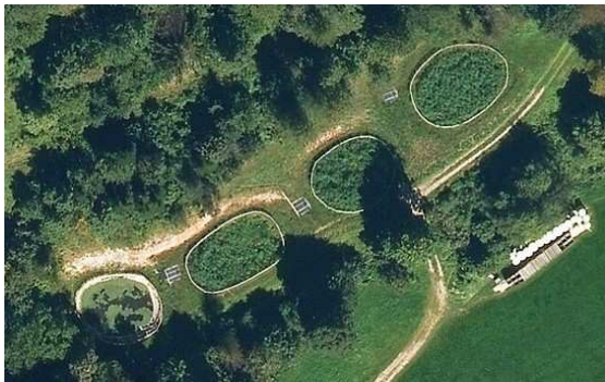
Lage der Kläranlage, Fennberg (Geobrowser der Autonomen Provinz Bozen)
