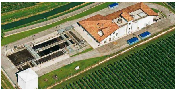
Luftbild der Anlage, Margreid (Foto: eco center AG)
