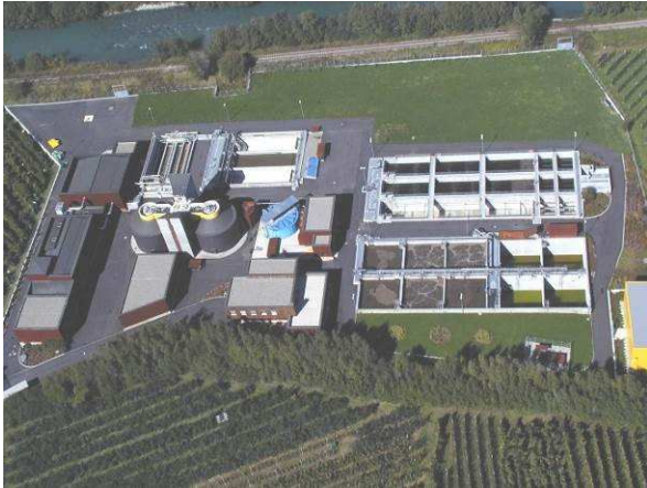
Luftbild der Anlage, Mittelvinschgau (Foto: Amt für Gewässerschutz)
