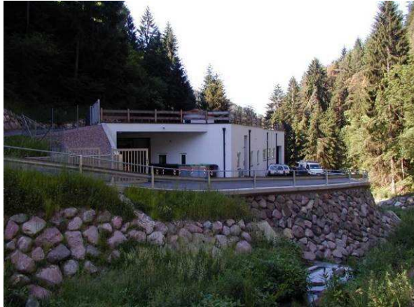
Ansicht der Anlage, Mölten (Foto: Amt für Gewässerschutz)
