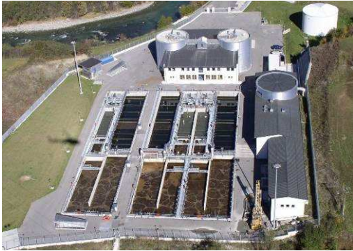
Luftbild der Anlage, Wipptal (Foto: Amt für Gewässerschutz)
