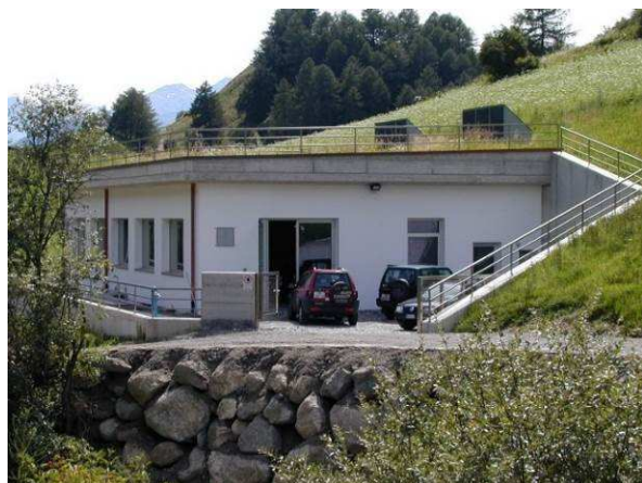
Außenansicht der Anlage, Matsch (Foto: Amt für Gewässerschutz)
