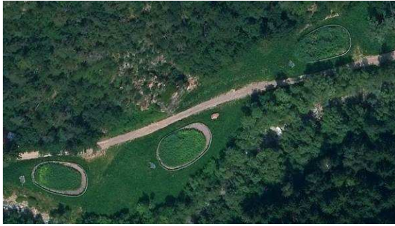
Lage der Kläranlage, Hohen (Geobrowser der Autonomen Provinz Bozen)
