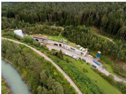
Luftbild der Anlage, St. Lorenzen (Foto: Amt für Gewässerschutz)
