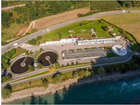
Luftbild der Anlage, Mühlbach (Foto: Amt für Gewässerschutz)
