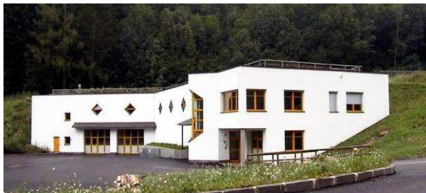
Frontansicht der Anlage, Lügen (Foto: Amt für Gewässerschutz)
