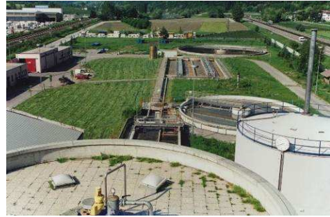
Detail der Anlage, Brixen (Foto: Amt für Gewässerschutz)
