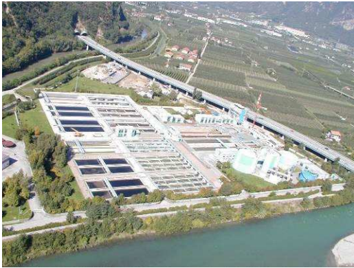
Luftbild der Anlage, Bozen (Foto: Amt für Gewässerschutz)
