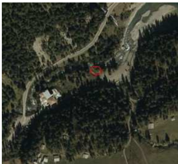
Lage der Kläranlage, Zufritt (Datenbank der Autonomen Provinz Bozen)
