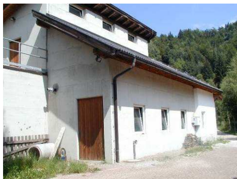
Detail der Anlage, Wangen (Foto: Amt für Gewässerschutz)
