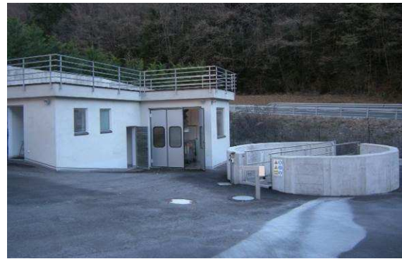
Detail der Anlage, Bundschen (Foto: Amt für Gewässerschutz)
