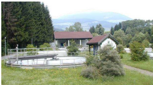
Detail der Anlage, Sarntal (Foto: Amt für Gewässerschutz)
