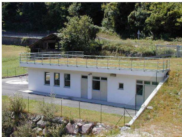
Frontansicht der Anlage, Laurein (Foto: Amt für Gewässerschutz)
