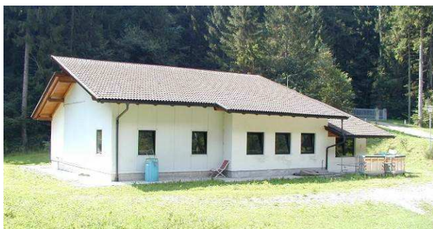
Außenansicht der Anlage, St. Pankraz (Foto: Amt für Gewässerschutz)
