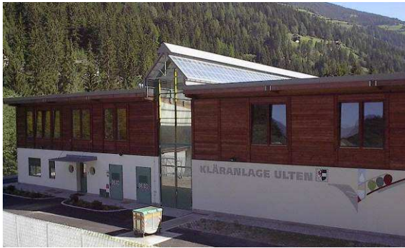
Frontansicht der Anlage, Ulten (Foto: Amt für Gewässerschutz)
