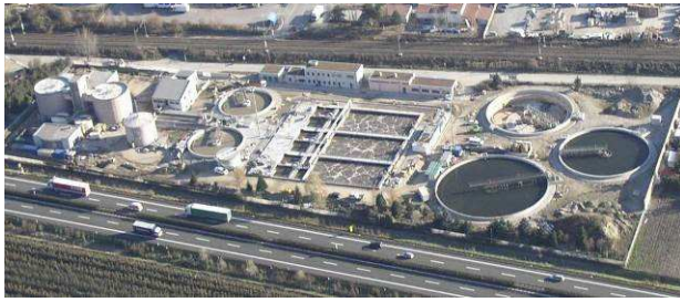
Luftbild der Anlage, Brixen (Foto: Amt für Gewässerschutz)
