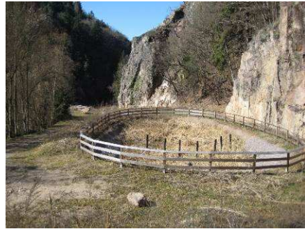
Detail der Anlage, Hohen (Foto: Amt für Gewässerschutz)
