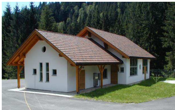
Frontansicht der Anlage, Proveis (Foto: Amt für Gewässerschutz)
