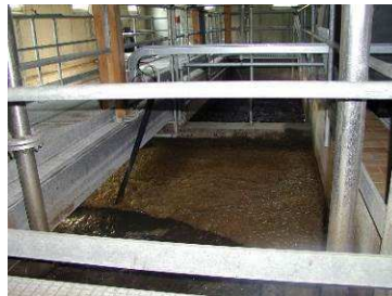
Detail der Anlage, Lengstein (Foto: Amt für Gewässerschutz)
