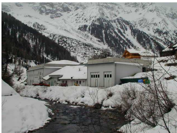
Frontansicht der Anlage, Suldén (Foto: Amt für Gewässerschutz)
