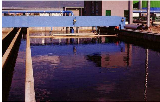
Detail der Anlage, Bozen (Foto: Amt für Gewässerschutz)
