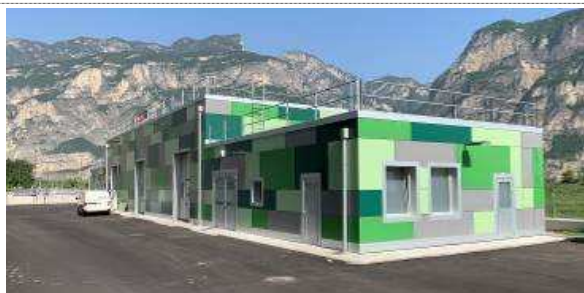
Anlage Salurn (Foto: Amt für Gewässerschutz)
