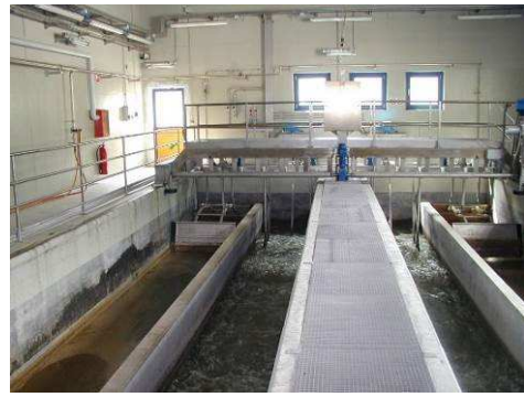
Detail der Anlage, Wipptal (Foto: Amt für Gewässerschutz)
