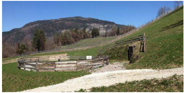
Detail der Anlage, Gschnon (Foto: Amt für Gewässerschutz)
