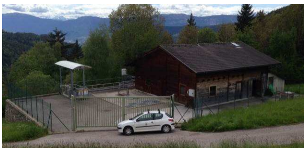
Bild der Anlage, Oberinn (Foto: Amt für Gewässerschutz)
