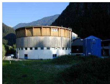
Detail der Anlage, Pontives (Foto: Amt für Gewässerschutz)
