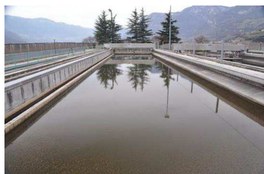
Detail der Anlage, Tramin (Foto: Amt für Gewässerschutz)
