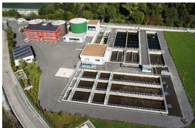
Luftbild der Anlage, Obervinschgau (Foto: Amt für Gewässerschutz)
