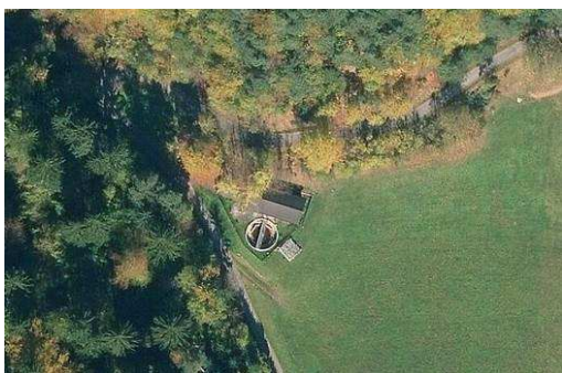
Luftbild der Kläranlage, Afing (Geobrowser der Autonomen Provinz Bozen)
