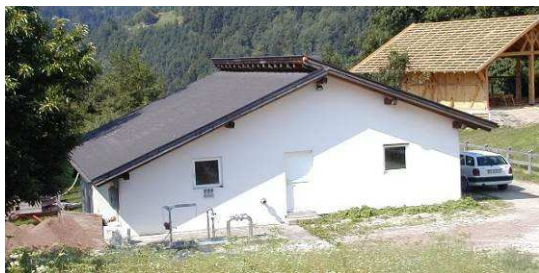
Frontansicht der Anlage, Lengstein (Foto: Amt für Gewässerschutz)
