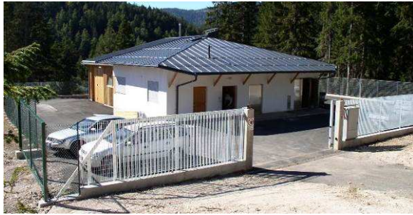
Frontansicht der Anlage, St. Felix (Foto: Amt für Gewässerschutz)
