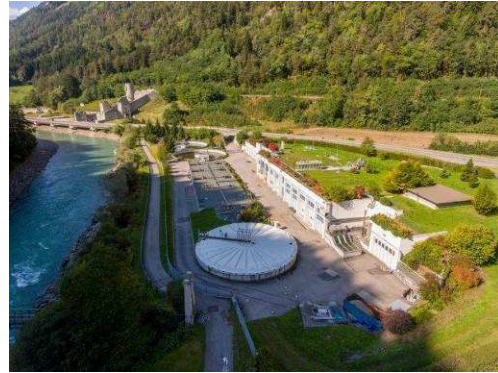
Detail der Anlage, Mühlbach (Foto: Amt für Gewässerschutz)
