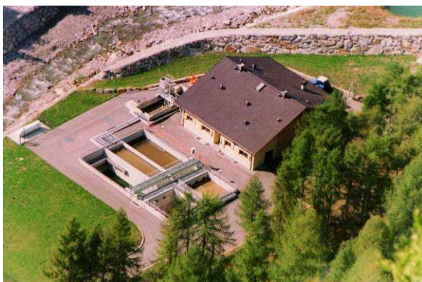
Luftbild der Anlage, Schnals, Foto: Amt für Gewässerschutz)
