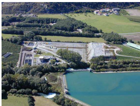
Luftbild der Anlage, Obervinschgau (Foto: Amt für Gewässerschutz)
