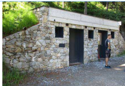
Immagine dell'impianto di depurazione
