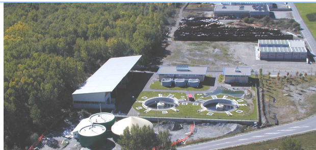
Immagine dell'impianto di depurazione
