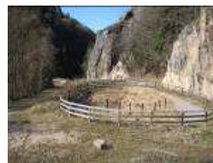
Immagine dell'impianto di depurazione
