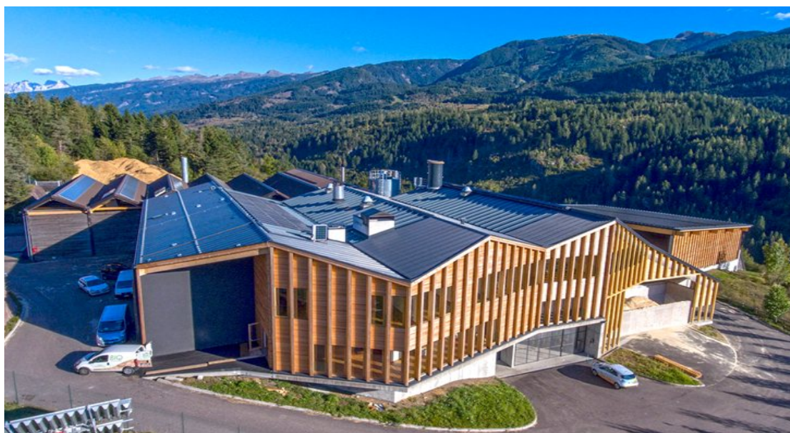
Vista della centrale termica di Cavalese con dettaglio della facciata e dei sistemi fotovoltaici.
