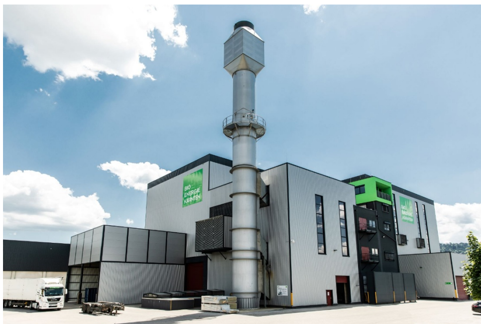
Centrale di Teleriscaldamento a Klagenfurt Est (AT)
