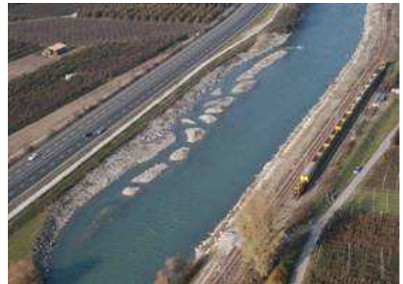
Fig. 24 Allargamenti d'alveo eseguiti sul Torrente Aurino e sul Fiume Adige
