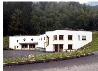
Immagine dell'impianto di depurazione
