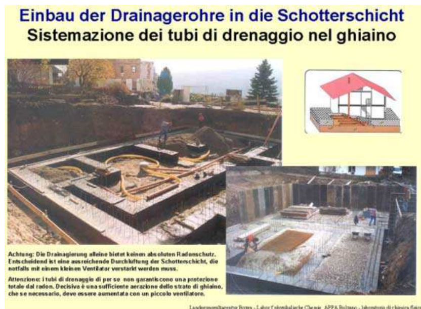
Figura 20) Realizzazione pratica di un sistema d'aspirazione dell'aria dal sottosuolo per mezzo di una rete di tubi di drenaggio incorporati nella ghiaia.
