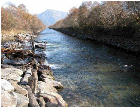
Abb. 103 Der begradigte Verlauf des Eisack am Zusammenfluss mit dem Ridnauner Bach
