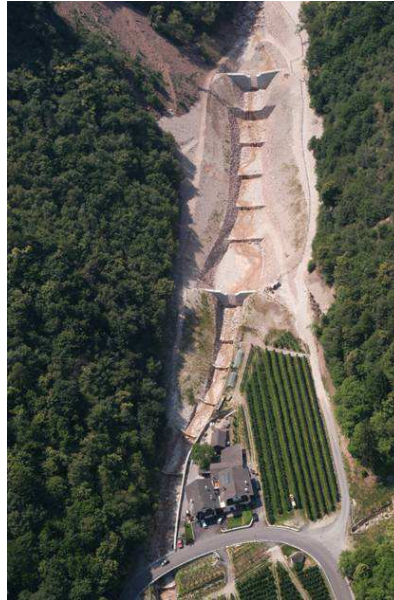
Abb. 76 Verbauungsmaß- nahmen am Grissianerbach zum Schutz von Nals
