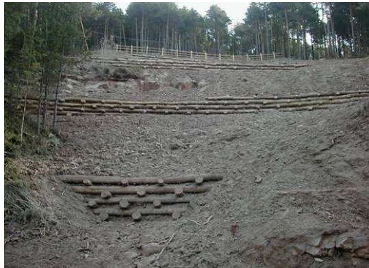
Abb. 81 Krainerwände aus Holz mit Steinflüllungen
