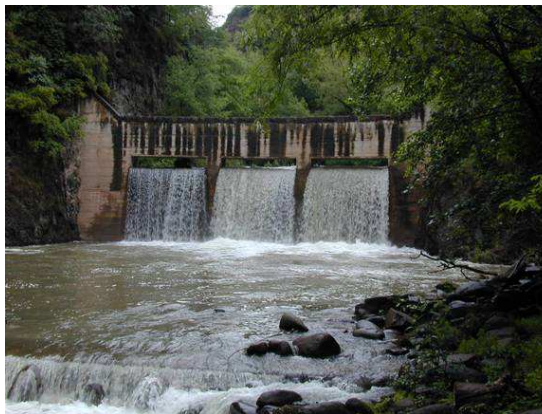
Abb. 110 Beispiel einer Wildbachverbauung
