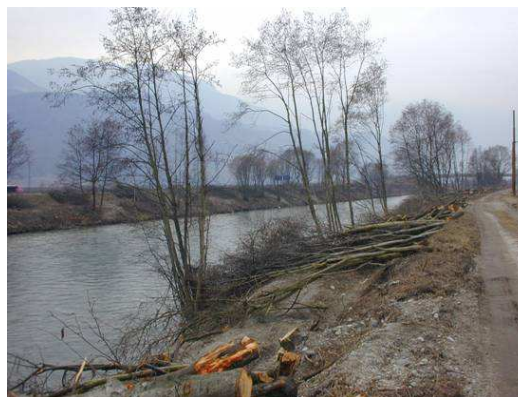
Abb. 72 Beseitigung der Ufervegetation
