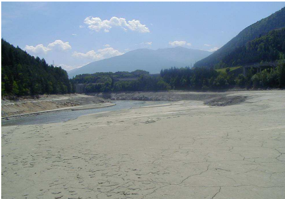
Abb. 114 Stauraumspülung im Staubecken von Franzensfeste
