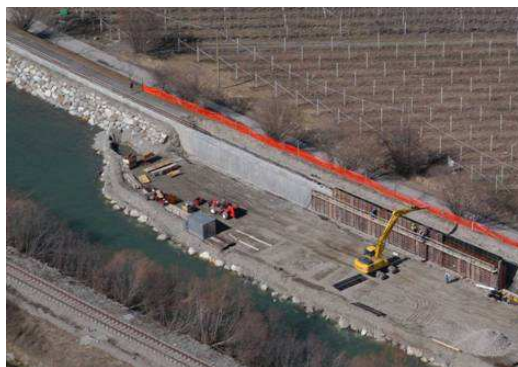
Abb. 71 Arbeiten zur Verstärkung des Etschdammes mittels einer Schlitzwand
