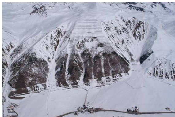
Abb. 85 Lawinenverbauung zum Schutz einer Siedlung
