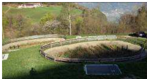
Immagine dell'impianto di depurazione
