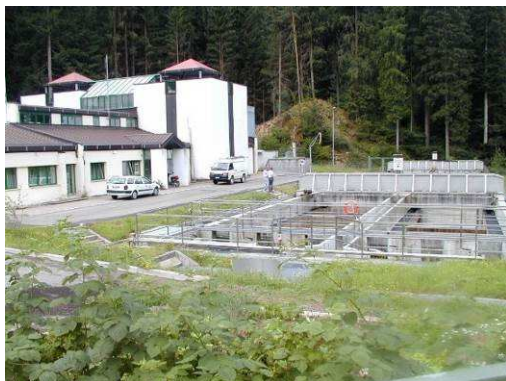
Panoramica impianto, Val d'Ega (foto Ufficio Tutela acque)
