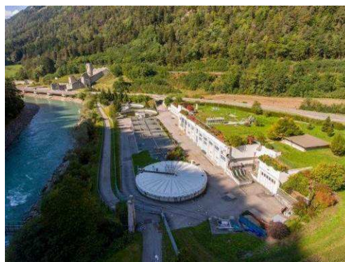
Particolare impianto, Bassa Pusteria (foto Ufficio Tutela acque)
