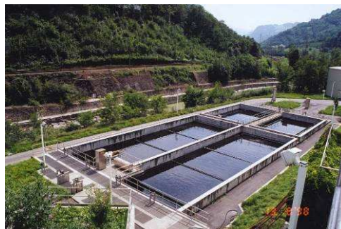
Particolare impianto, Bassa Valle Isarco (foto Ufficio Tutela acque)
