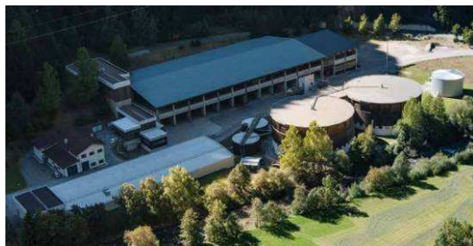
Panoramica impianto, Pontives (foto Ufficio Tutela acque)
