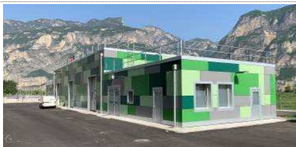
Panoramica impianto, Salorno (foto Ufficio Tutela acque)
