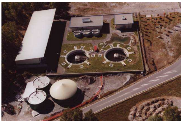
Particolare impianto, Prader Sand (foto Ufficio Tutela acque)
