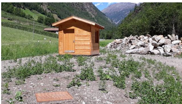
Panoramica impianto, Talele (Ufficio Tutela acque)
