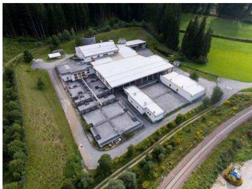
Panoramica impianto, San Candido-Sesto (foto Ufficio Tutela acque)
