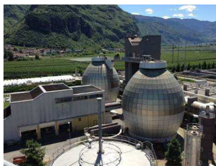
Particolare impianto, Bronzolo (foto Ufficio Tutela acque)
