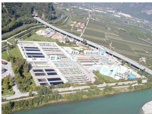
Panoramica impianto, Bolzano (foto Ufficio Tutela acque)
