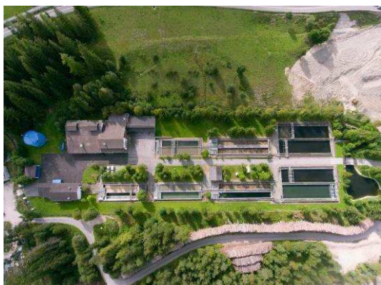
Panoramica impianto, Sompunt (foto Ufficio Tutela acque)
