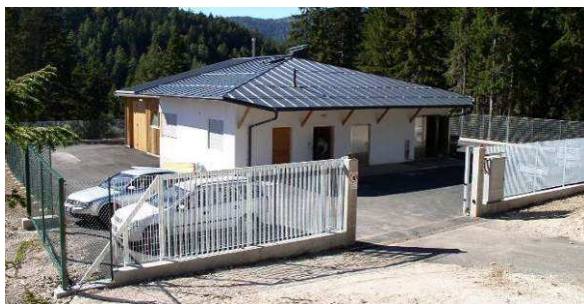
Panoramica impianto, San Felice (foto Ufficio Tutela acque)
