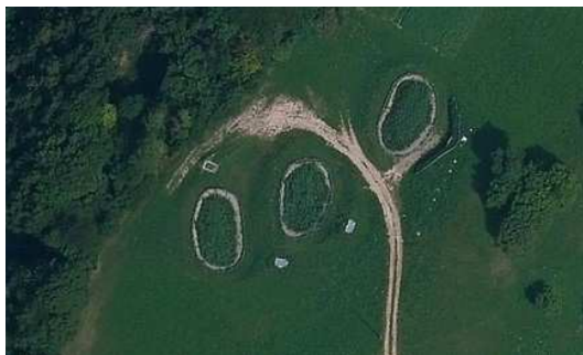
Ubicazione impianto, Casignano (Geobrowser della Provincia Autonoma di Bolzano)
