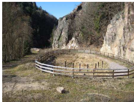
Particolare impianto, Olmi (foto Ufficio Tutela acque)
