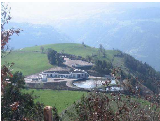
Panoramica impianto, Siffiano (foto Ufficio Tutela acque)
