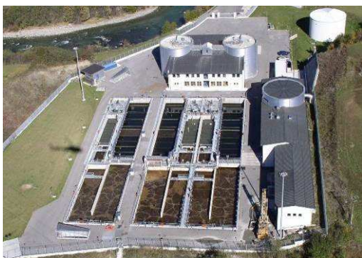
Panoramica impianto, Wipptal (foto Ufficio Tutela acque)
