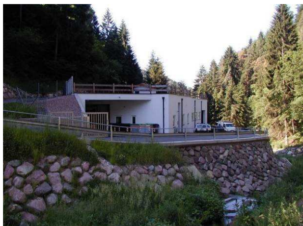
Panoramica impianto, Meltina (foto Ufficio Tutela acque)
