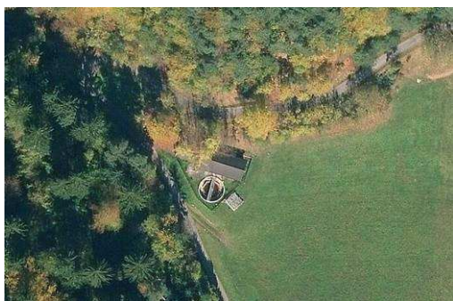
Panoramica impianto, Avigna (Geobrowser della Provincia Autonoma di Bolzano)
