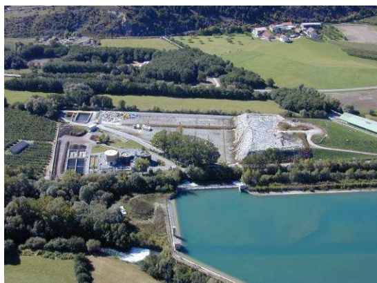
Panoramica impianto, Alta Val Venosta (foto Ufficio Tutela acque)
