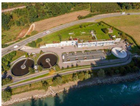
Panoramica impianto, Bassa Pusteria (foto Ufficio Tutela acque)
