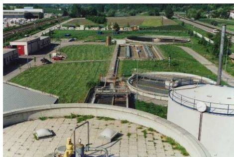
Particolare impianto, Bressanone (foto Ufficio Tutela acque)
