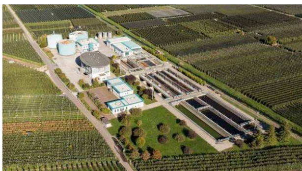
Panoramica impianto, Termeno (foto eco center spa)
