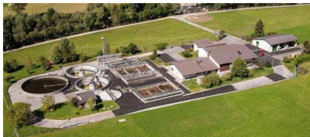
Panoramica impianto, Passiria (foto eco center spa)
