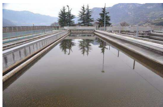
Particolare impianto, Termeno (foto Ufficio Tutela acque)
