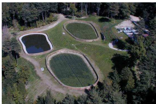
Panoramica impianto, Monticolo (foto Ufficio Tutela acque)
