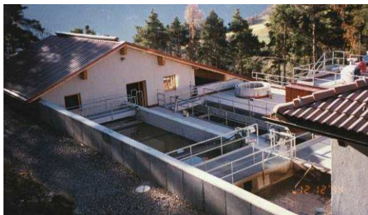
Panoramica impianto, Auna di Sotto (foto Ufficio Tutela acque)
