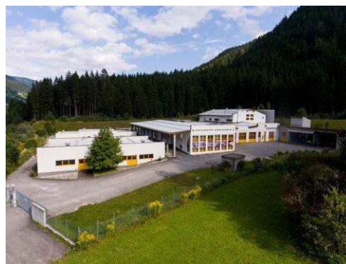
Particolare impianto, San Candido-Sesto (foto Ufficio Tutela acque)
