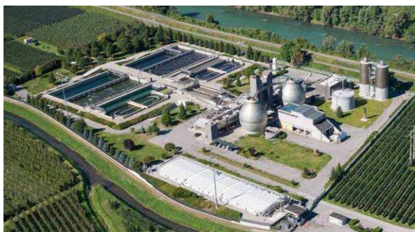
Panoramica impianto, Bronzolo (foto eco center)
