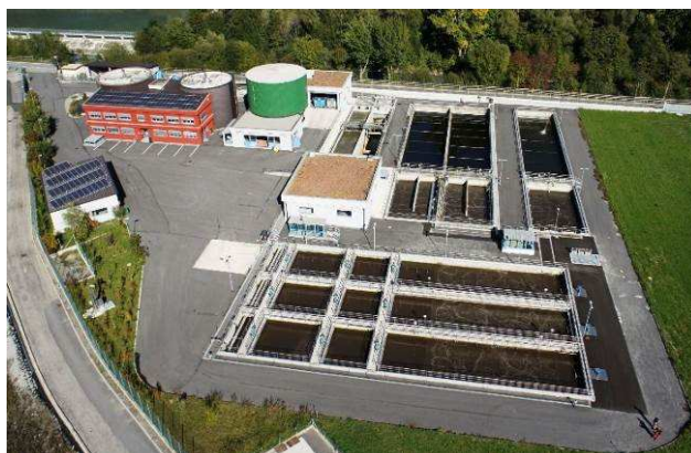
Panoramica impianto, Alta Val Venosta (foto Ufficio Tutela acque)
