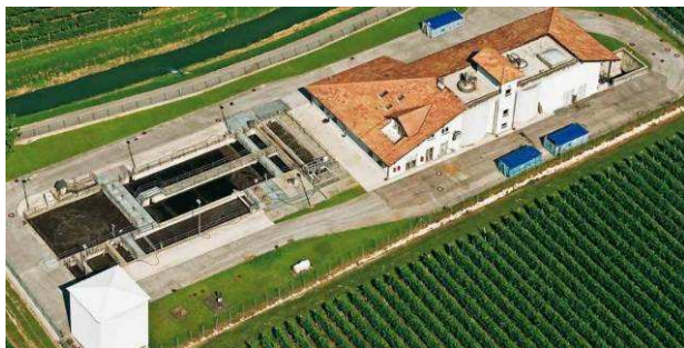
Panoramica impianto, Magrè (foto eco center spa)
