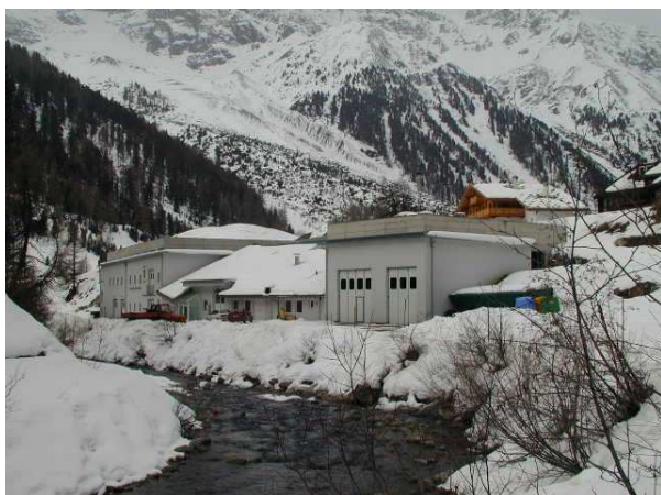
Panoramica impianto, Solda (foto Ufficio Tutela acque)
