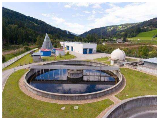
Particolare impianto, Wasserfeld (foto Ufficio Tutela acque)
