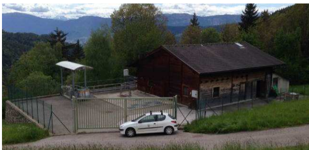
Panoramica impianto, Auna di Sopra (foto Ufficio Tutela acque)
