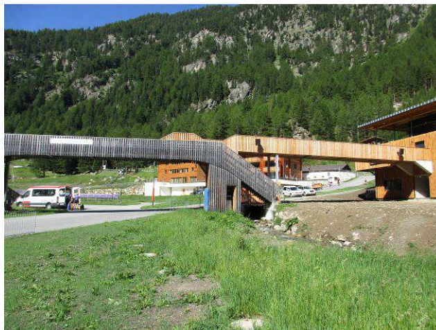
Immagine dell'impianto di depurazione
