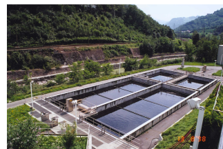
Immagine dell'impianto di depurazione
