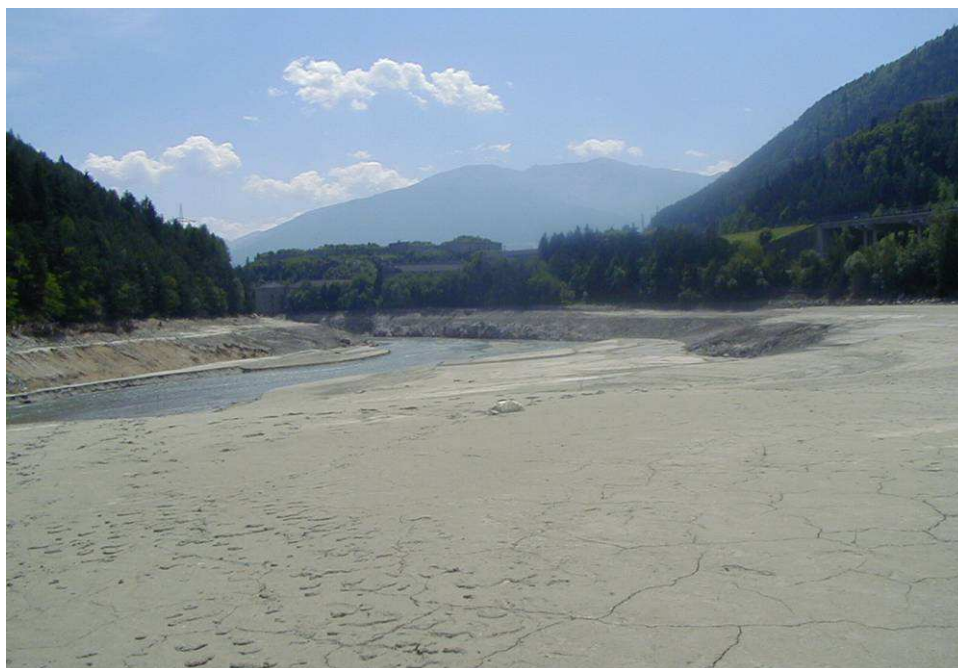
Abb. 32 Stauraumspülung im Staubecken von Franzensfeste
