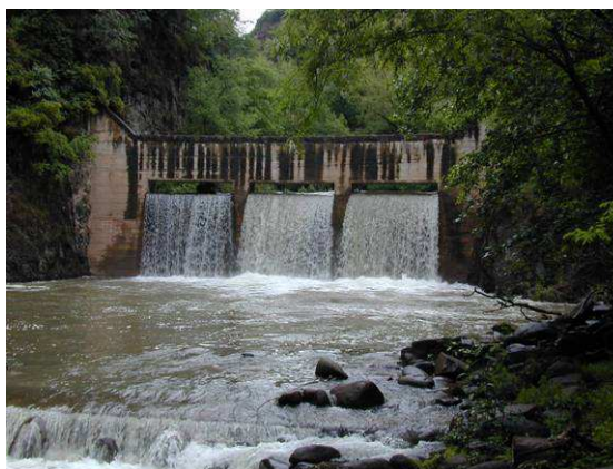
Abb. 29 Beispiel einer Wildbachverbauung
