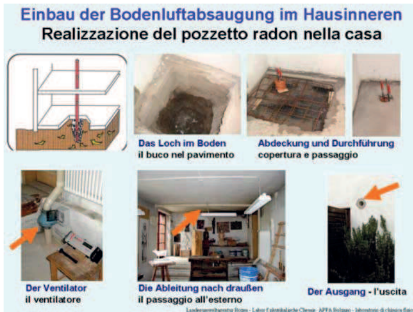
Abbildung 23) Einbau einer Bodenluftabsaugung im Hausinneren. Bei Erneuerung des Bodens können zum selben Zweck auch Drainagerohre verlegt werden.
