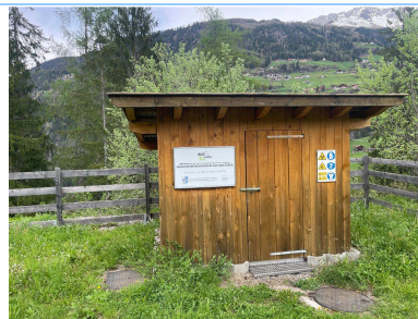
Immagine dell'impianto di depurazione
