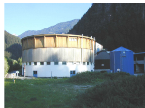
Immagine dell'impianto di depurazione
