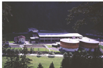
Immagine dell'impianto di depurazione
