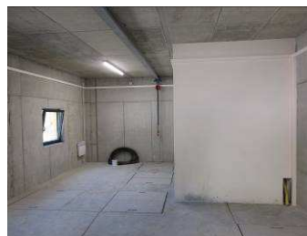
Immagine dell'impianto di depurazione
