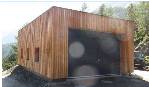
Immagine dell'impianto di depurazione
