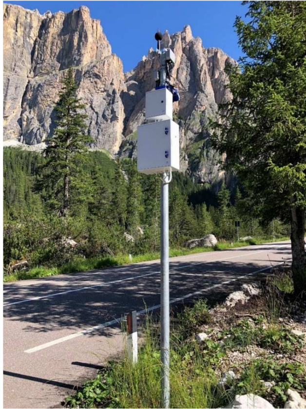
Bild 5: Messstation Pian Schiavaneis
